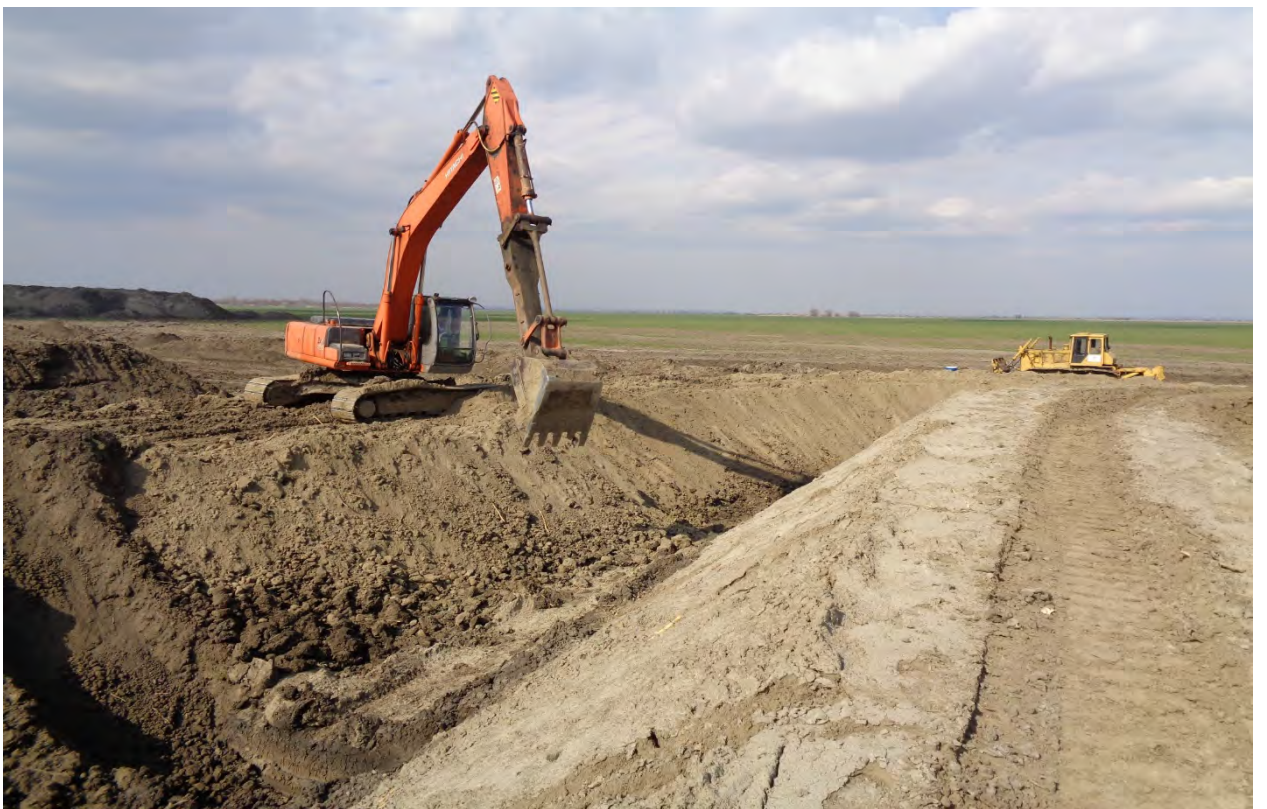
Устройство водоотводной канавы между картами №1и №2.
