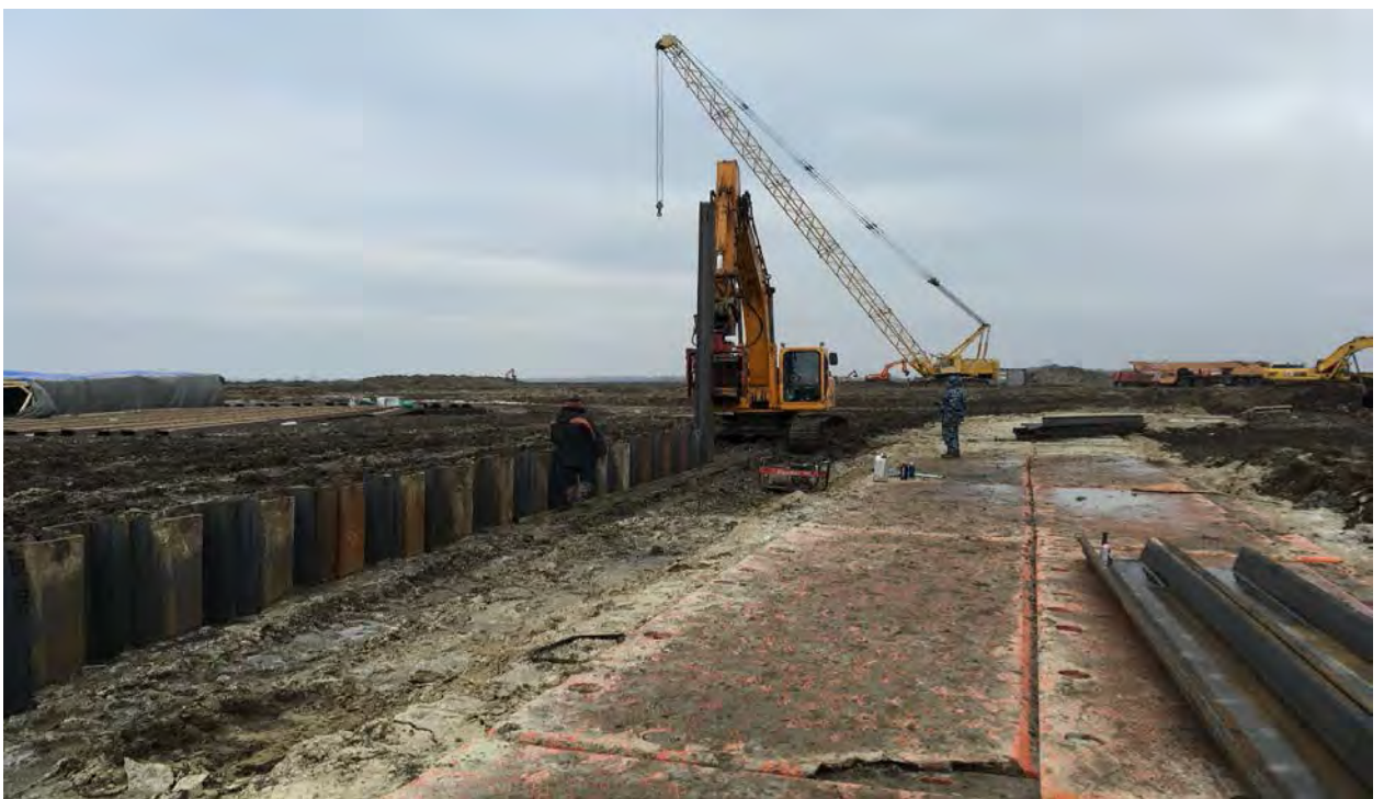
Правый берег. Погружение шпунта L=6м. (вибропогружатель MOVAX SPH80) Анкерный ряд.
