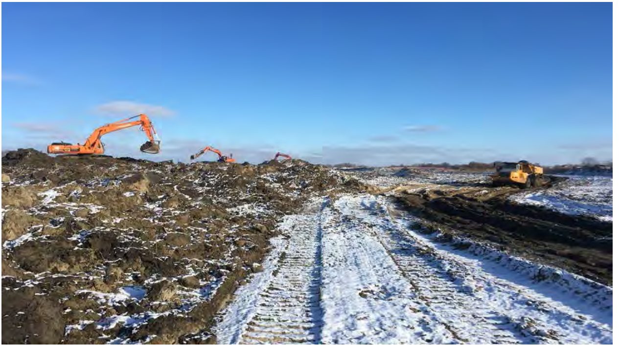
Малый остров. Снятие плодородного слоя грунта на малом острове.
