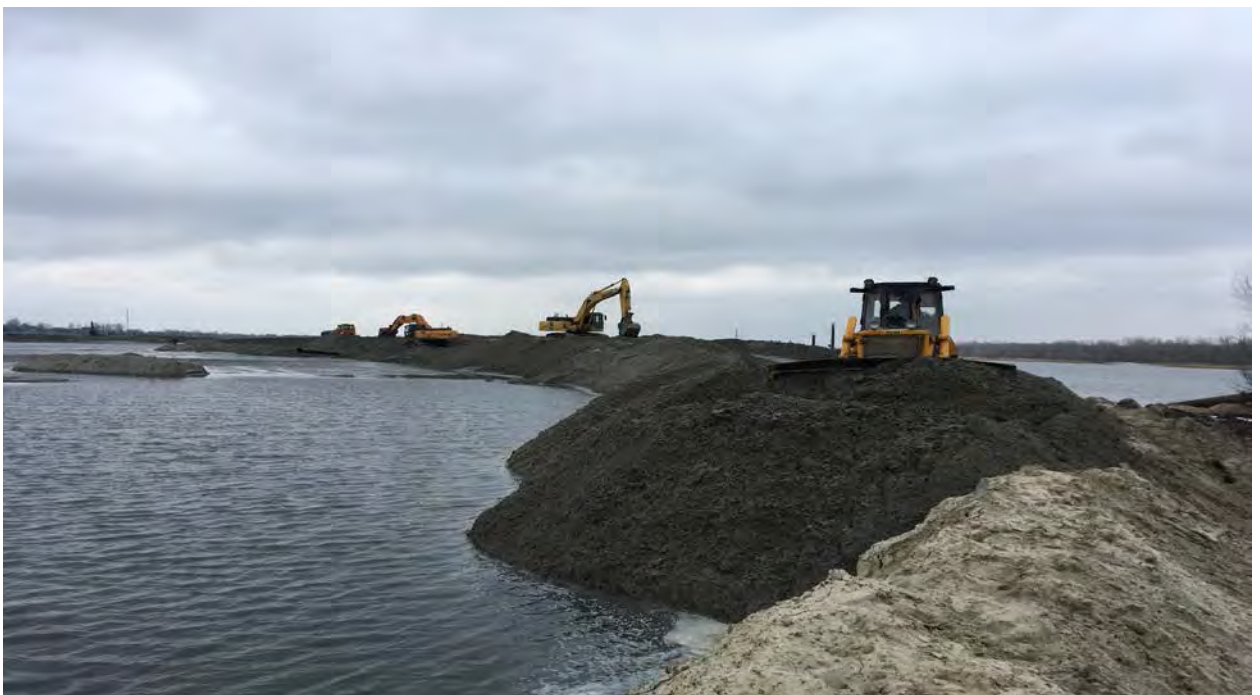
ОПСТВН. Усиление береговой линии дамбы первичной обваловки карты намыва №2.
