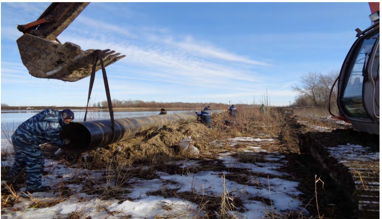
Большой остров. Сварка секции для перехода через р. Дон.
