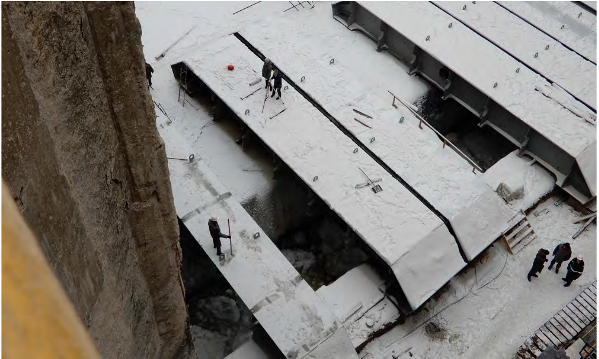
Измерение прогибов по напорной стороне.
