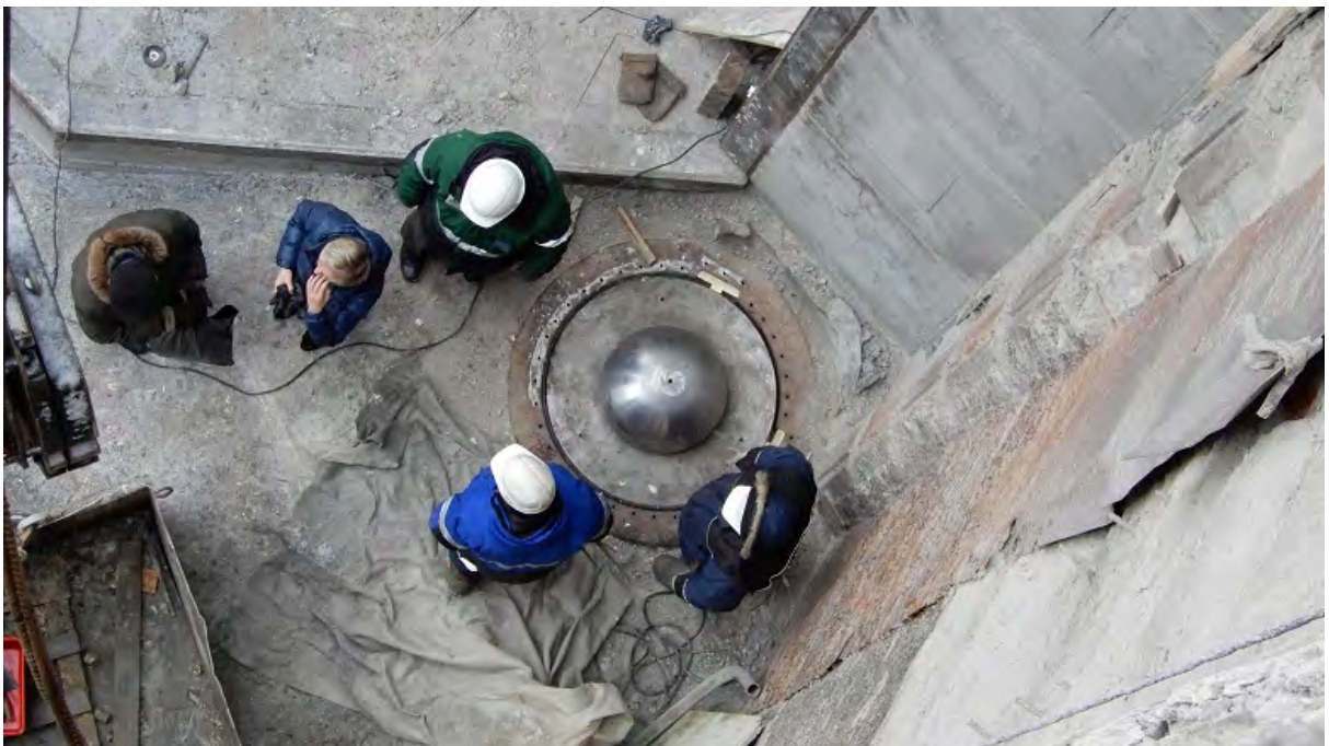
Проверка установки гриба пяты.
