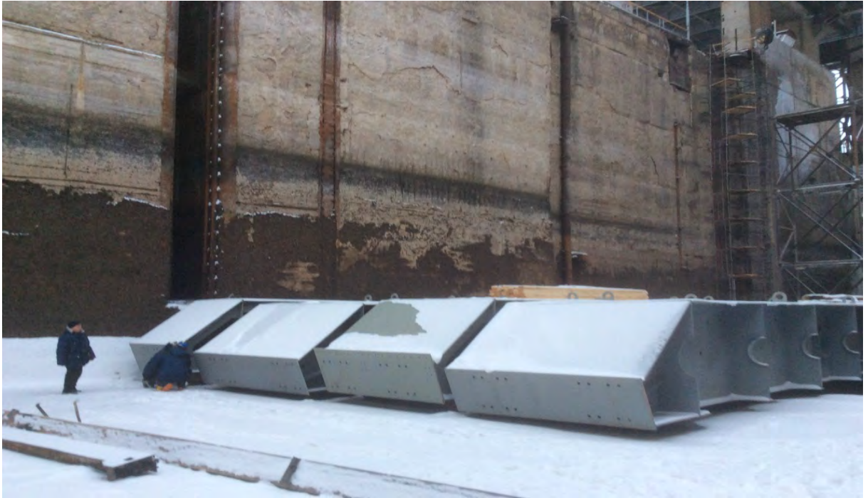
Визуально-измерительный контроль сварных швов.
