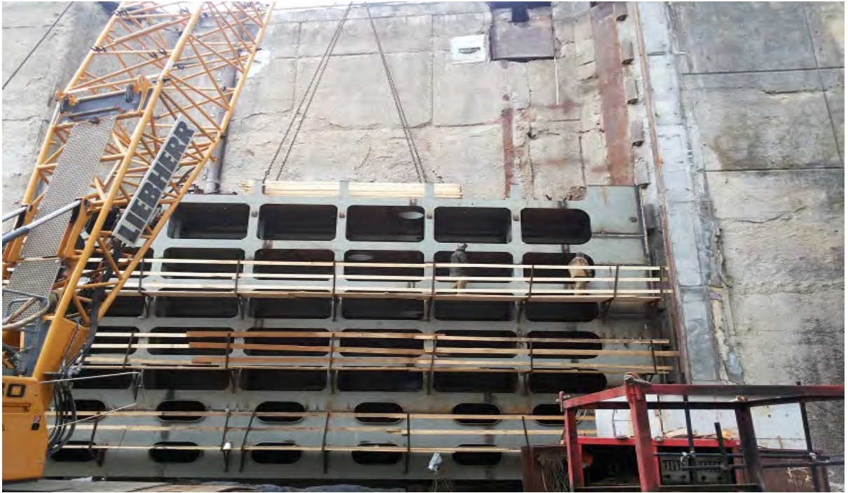
Монтаж марок в камере шлюза № 26.
