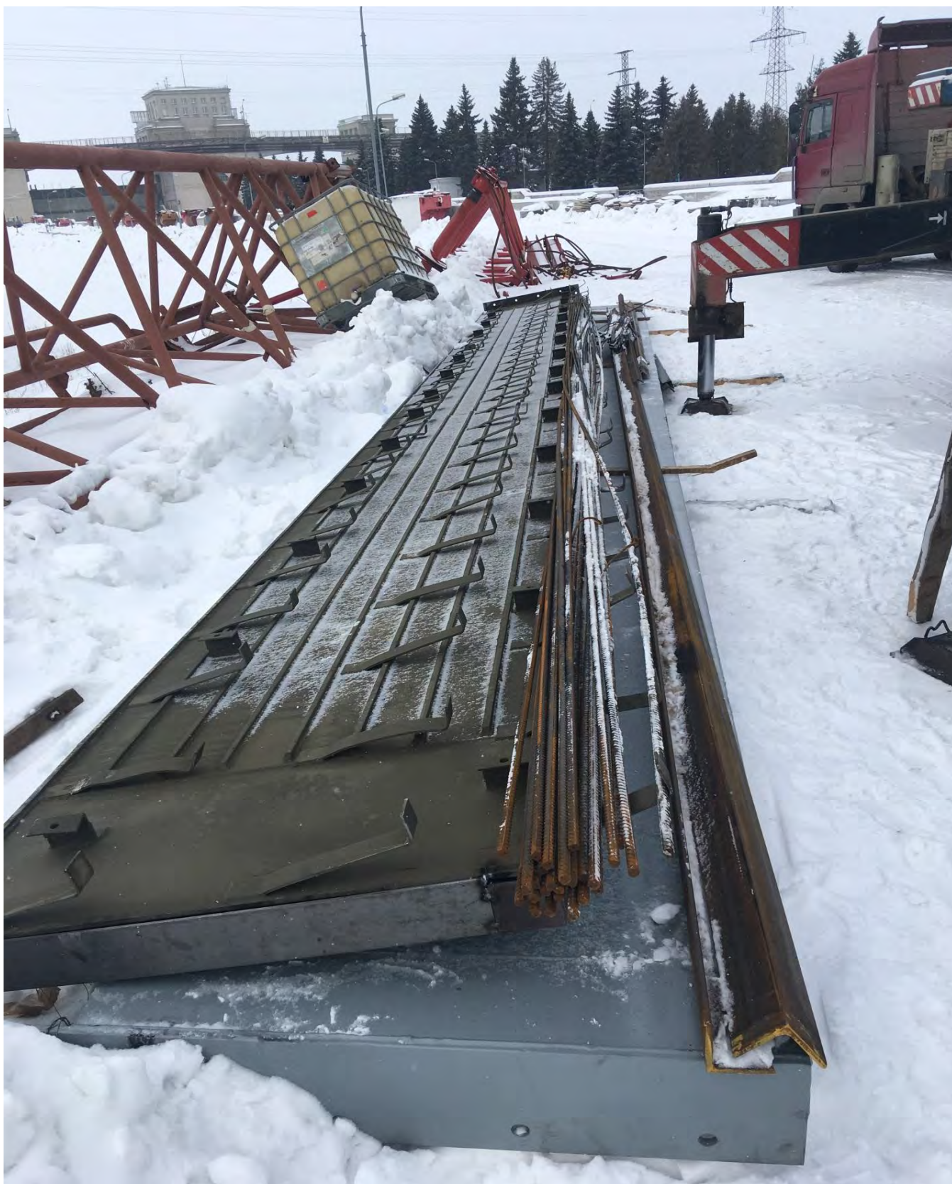
Выгрузка вертикальных закладных ниш батопорта, на береговой стенке камеры №14.
