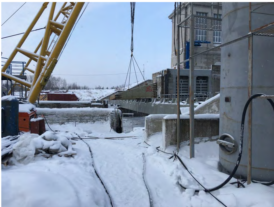
Монтаж упоров к нижней балке заградстройства на камере №14.
