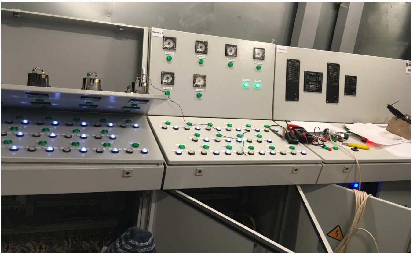
Монтаж шкафов питания батопорта.
