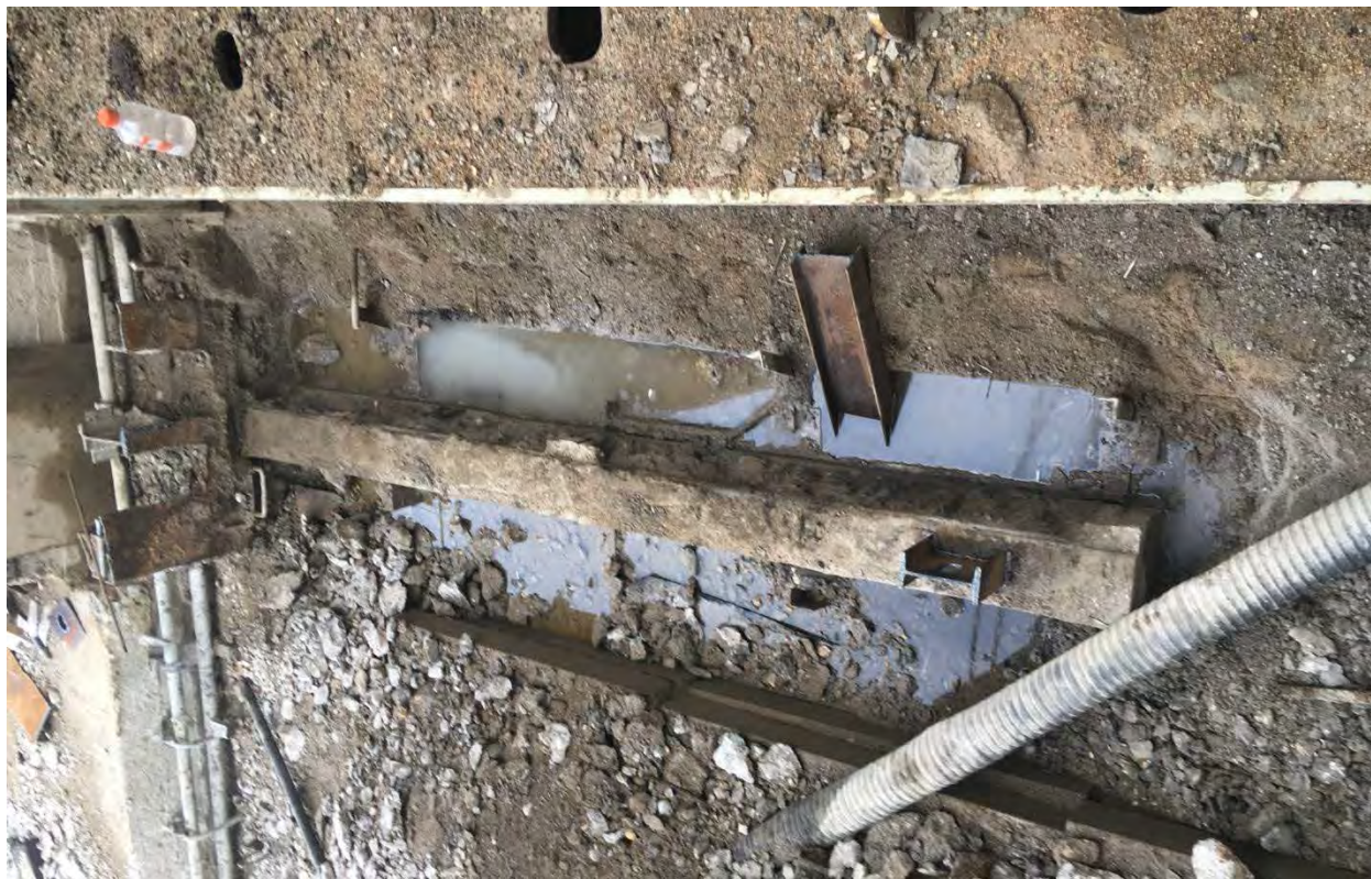
Демонтаж опорных закладных ниш батопорта на камере №14.
