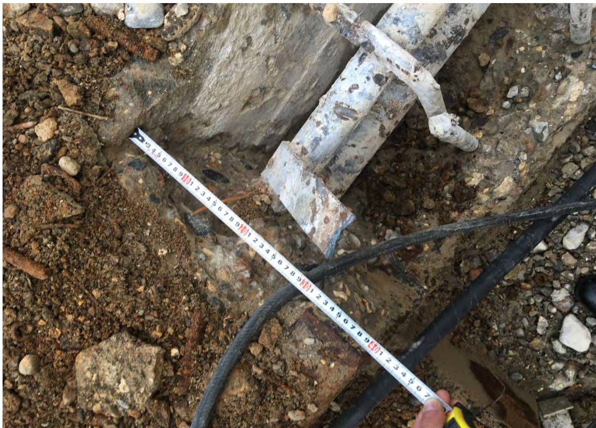
Рубка бетона опорной закладной на камере №14.
