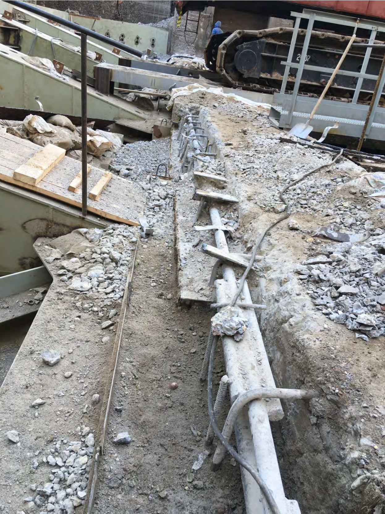
Демонтаж закладной порога на камере №14.
