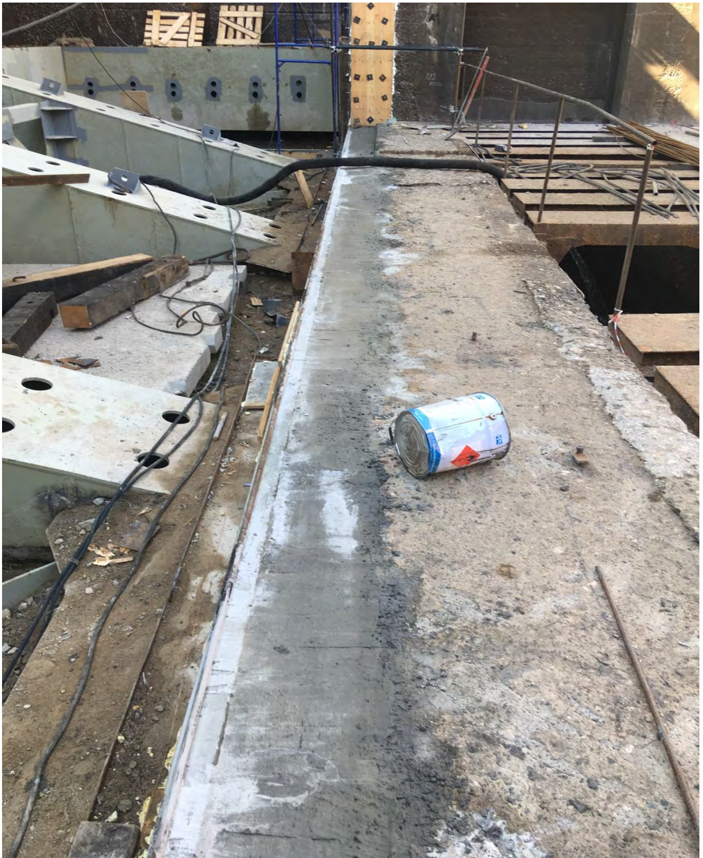
Бетонирование порога.
