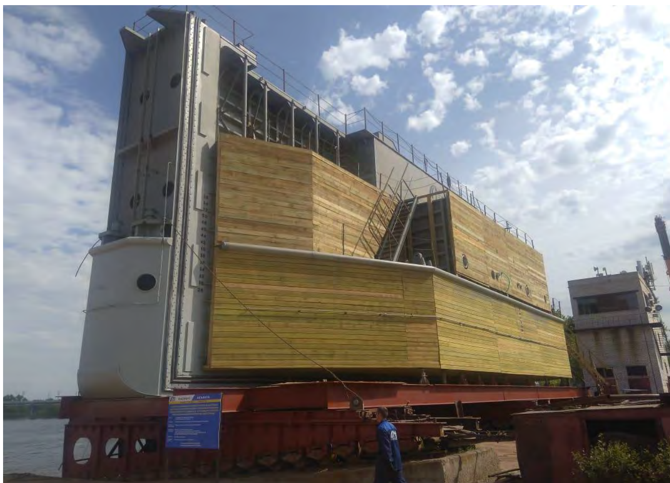
Монтаж отбойного бруса батопорта на заводе в г. Волгоград.
