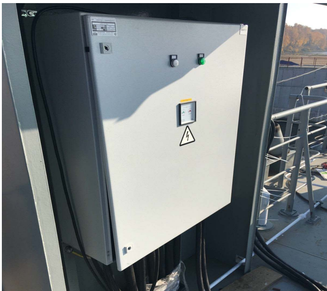
Монтаж шкафов питания батопорта.
