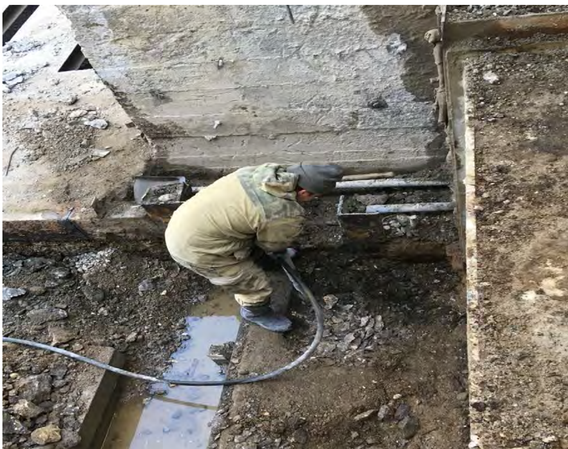
Рубка бетона опорной закладной на камере №14.
