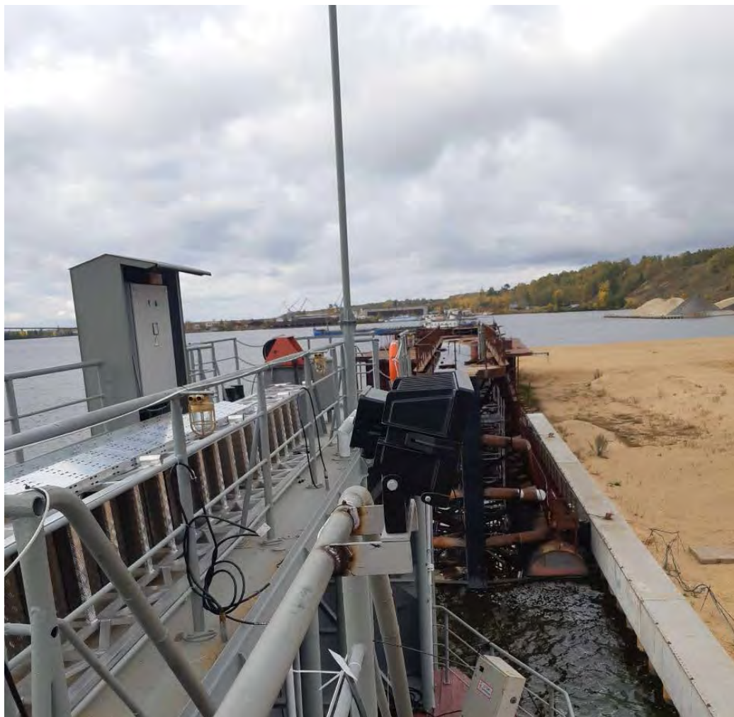
Монтаж ручных лебедок батопорта.
