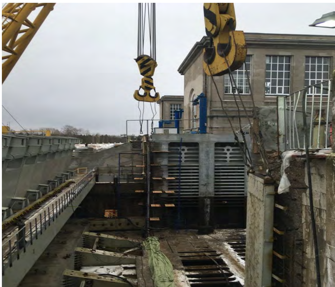
Монтаж левой закладной части бокового уплотнения батопорта.
