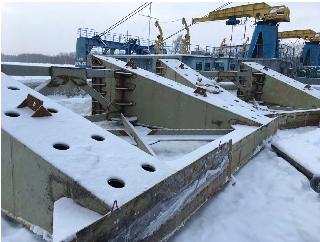
Демонтаж упоров нижней балки заградстройства с камеры №13.
