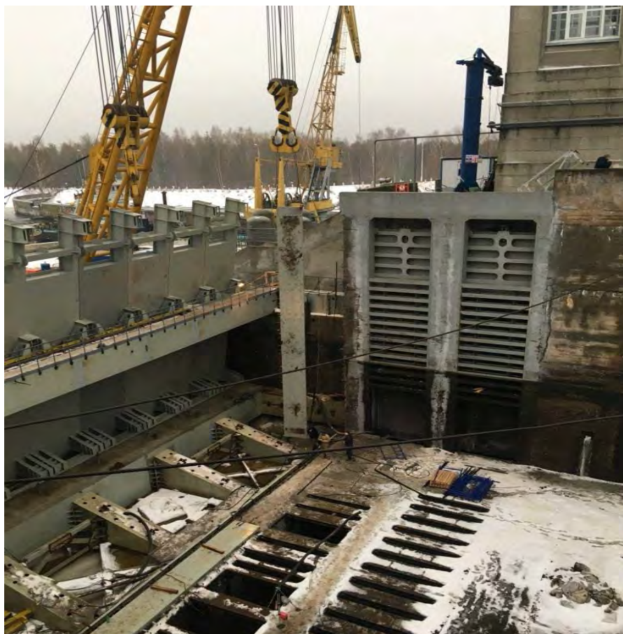
Монтаж правой закладной части бокового уплотнения батопорта.
