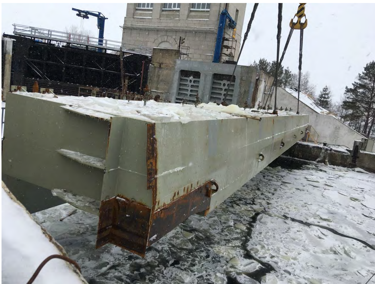
Демонтаж нижней балки заградустройства с камеры №13.
