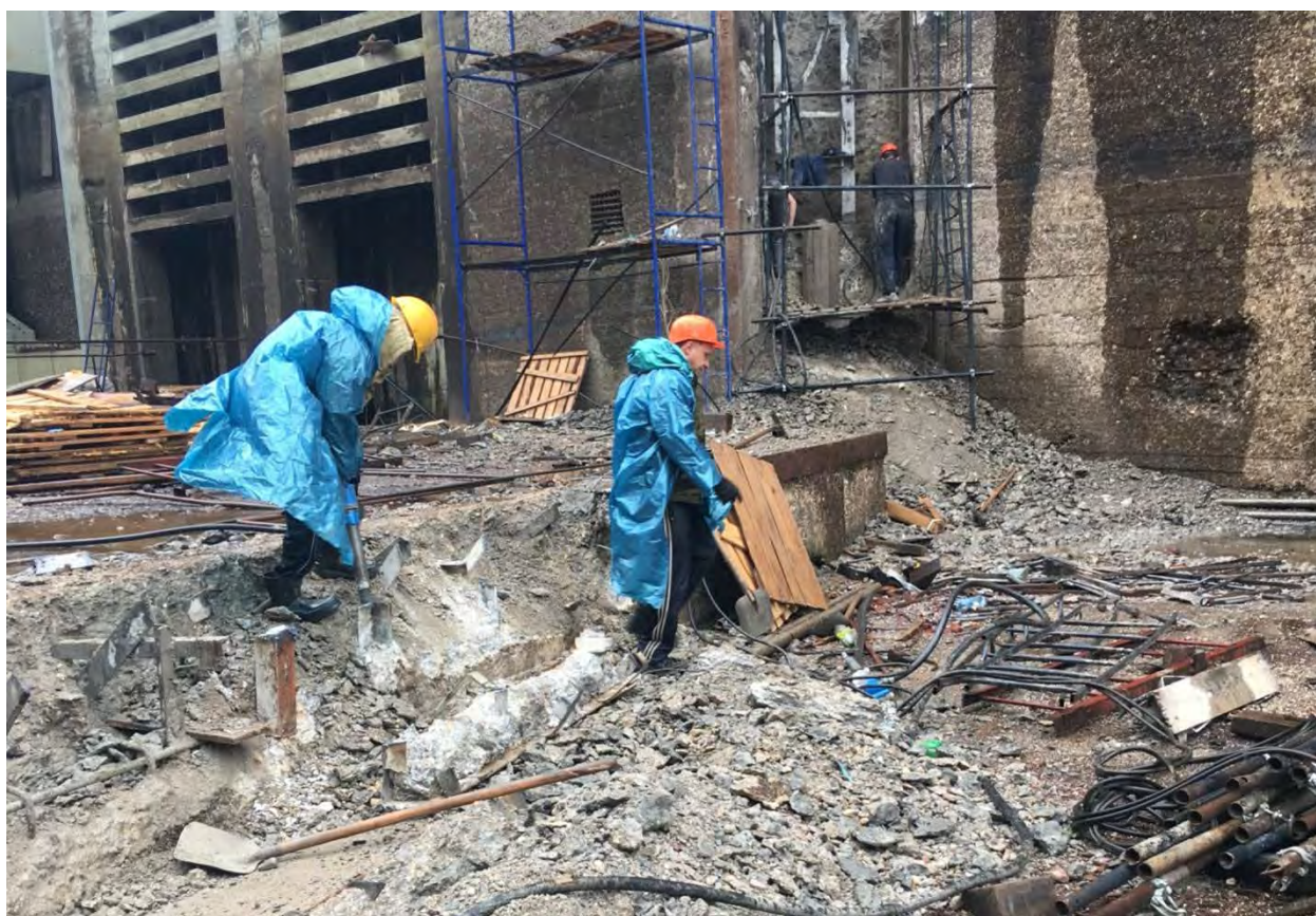
Рубка бетона и демонтаж закладной порога НДВ.
