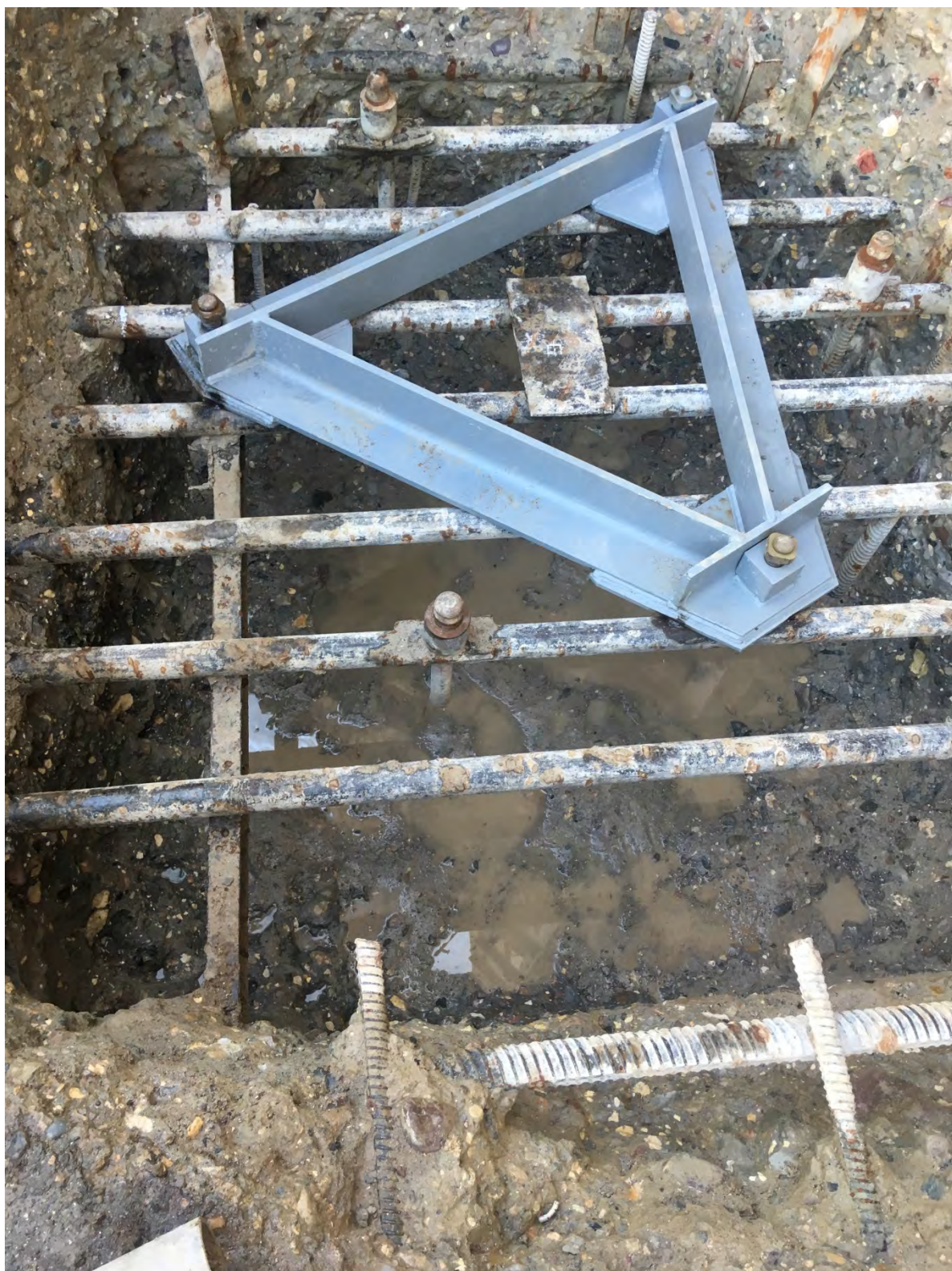
Монтаж рамы подпятников НДВ.
