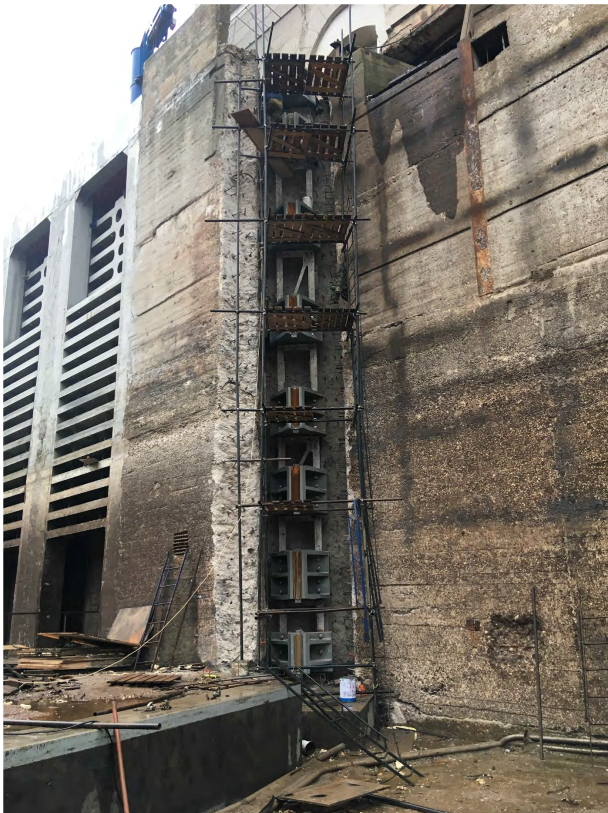
Смонтированный ряд упорных подушек береговой створки НДВ.
