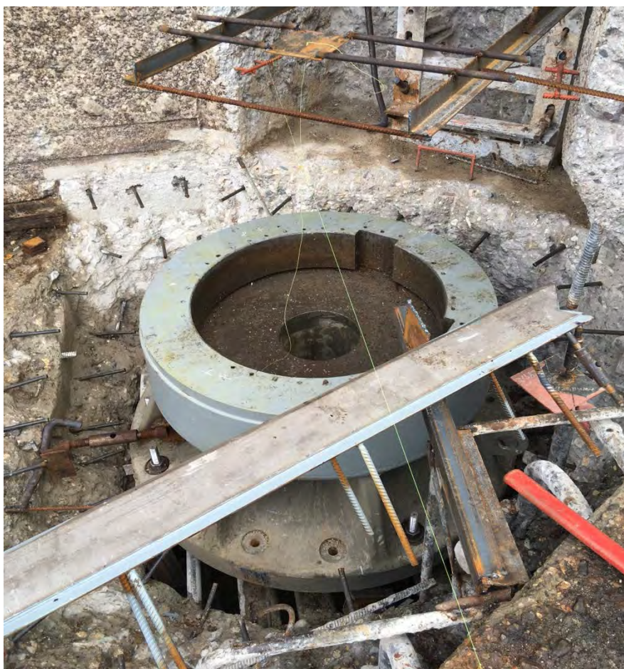
Монтаж подпятников НДВ.
