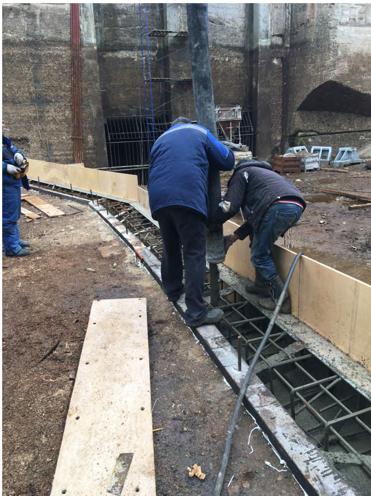
Бетонирование порога НДВ.
