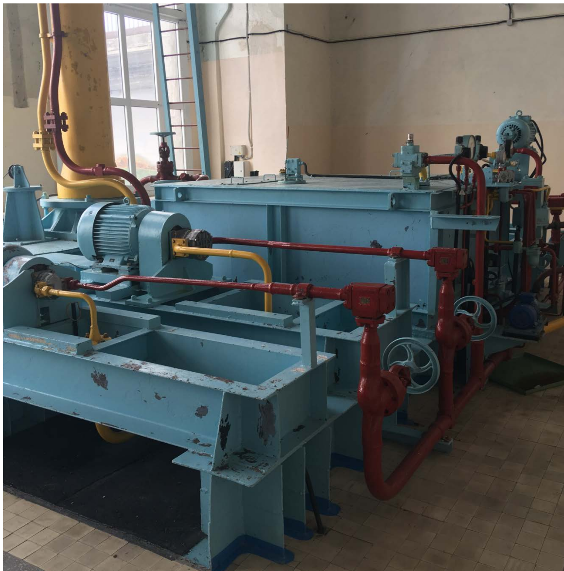
Демонтаж маслonaпорной установки (МНУ) верхних рабочих ворот (ВРВ).
