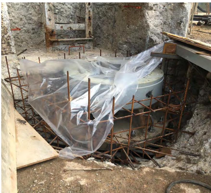
Армирование ниш подпятников НДВ.
