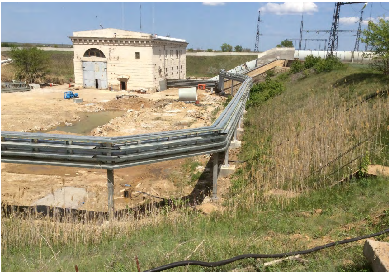
Фото 6. Монтаж траверс для прокладки силовых кабелей и кабелей управления от насосной станции в здание энерго-диспетчерского пункта
