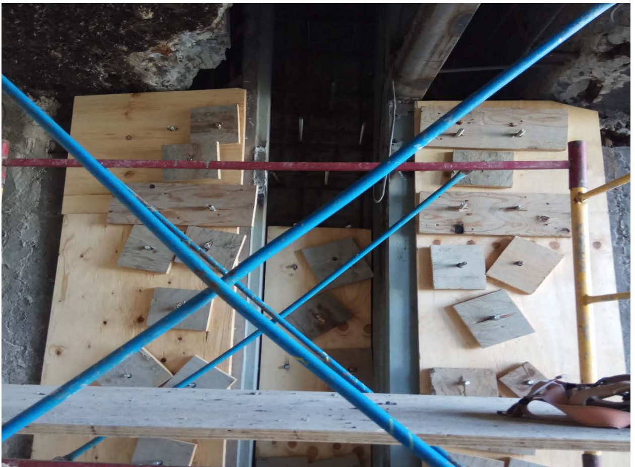
Фото 4, 5. Монтаж анкерных опор трубопровода нитки № 3 и устройство температурных швов на бетонных площадках
