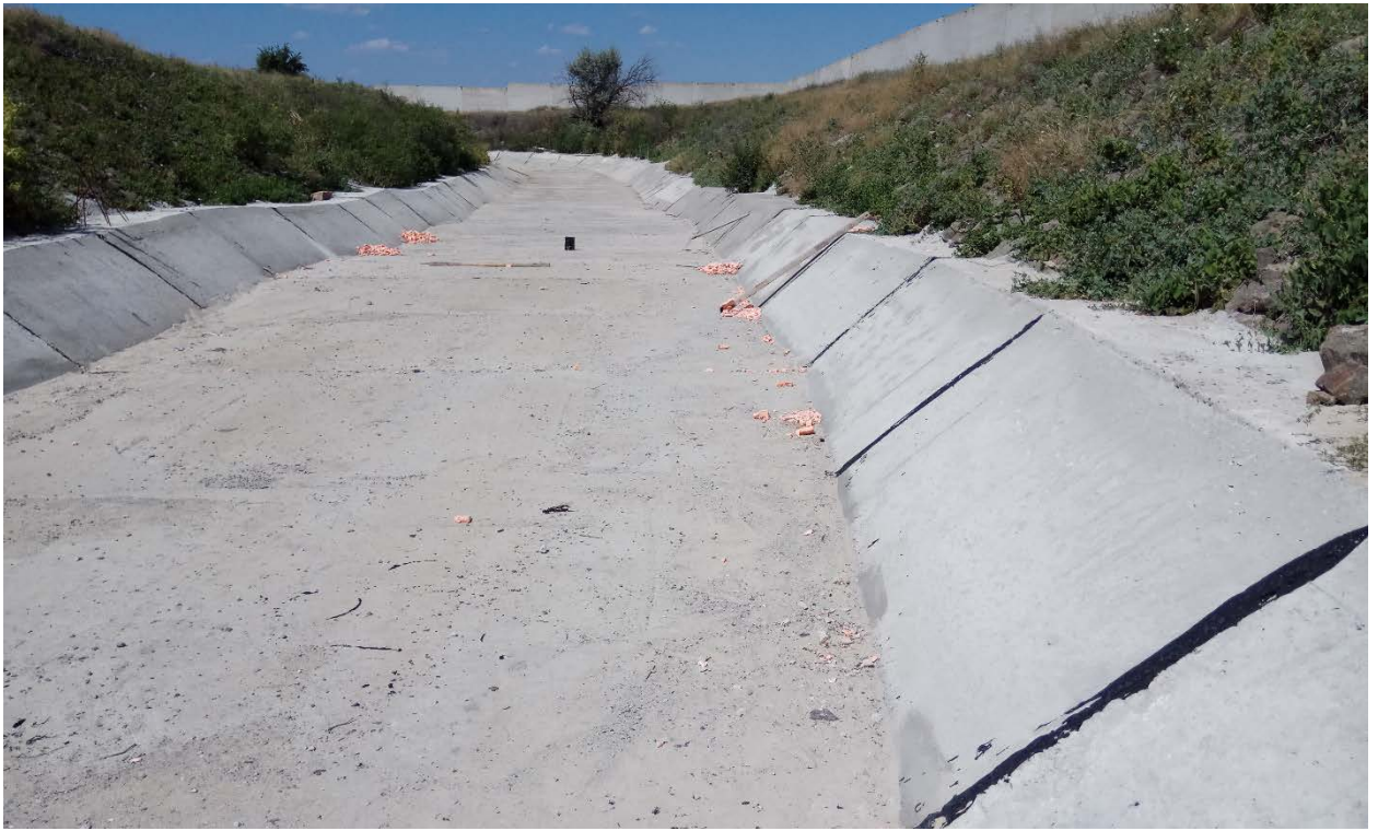
Фото 25,26,27,28,29. Реконструкция ливнеотводящих кюветов вдоль трубопроводов
