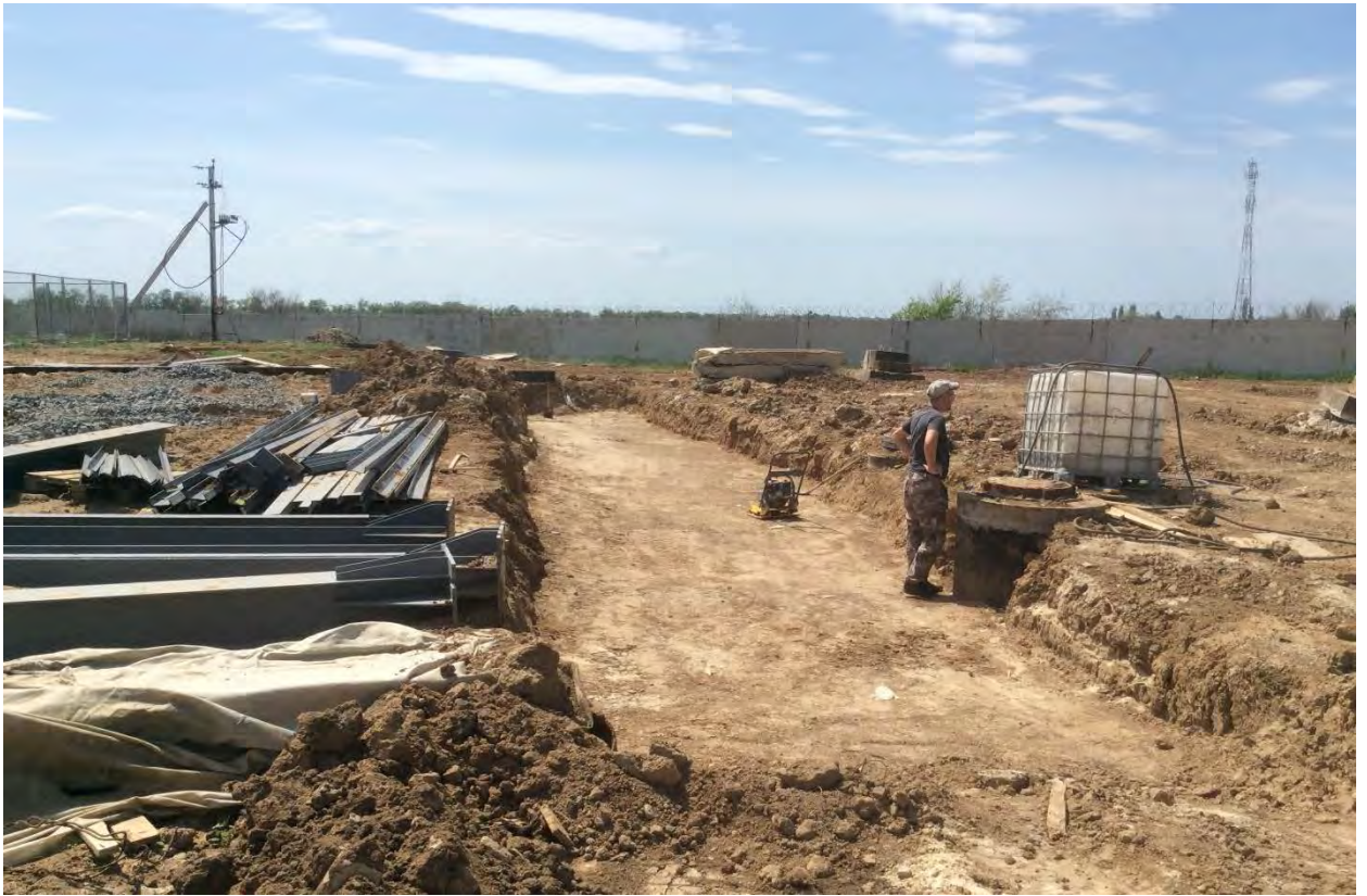
Фото 7. Снятие растительного слоя грунта для устройства опорной, монолитной плиты фундаментов энерго-диспетчерского пункта
