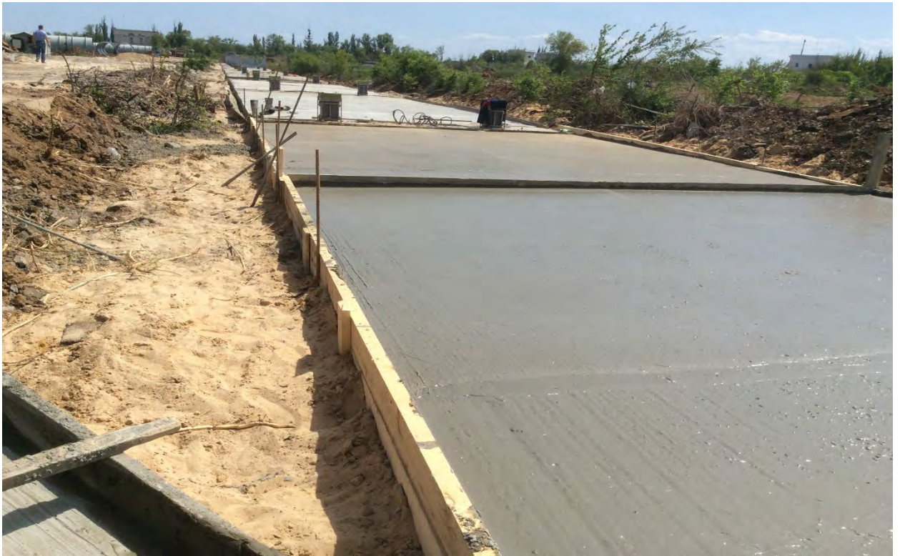
Фото 3,4,5. Разработка траншеи, отсыпка основания, армирование и бетонирование площадок под нитку №3 трубопровода Т-34
