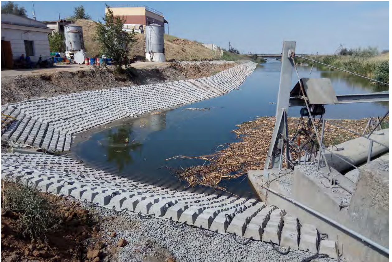
Фото 7,8,9,10. Крепление подводной и надводной части правого откоса канала № 135 из гибких бетонных матов УГЗБМ-305
