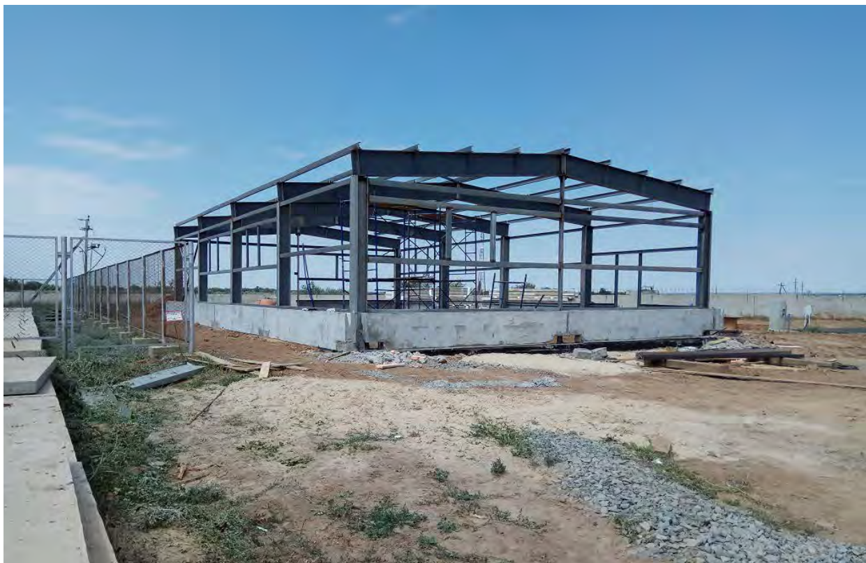
Фото 1. Монтаж цокольных панелей здания энерго-диспетчерского пункта
