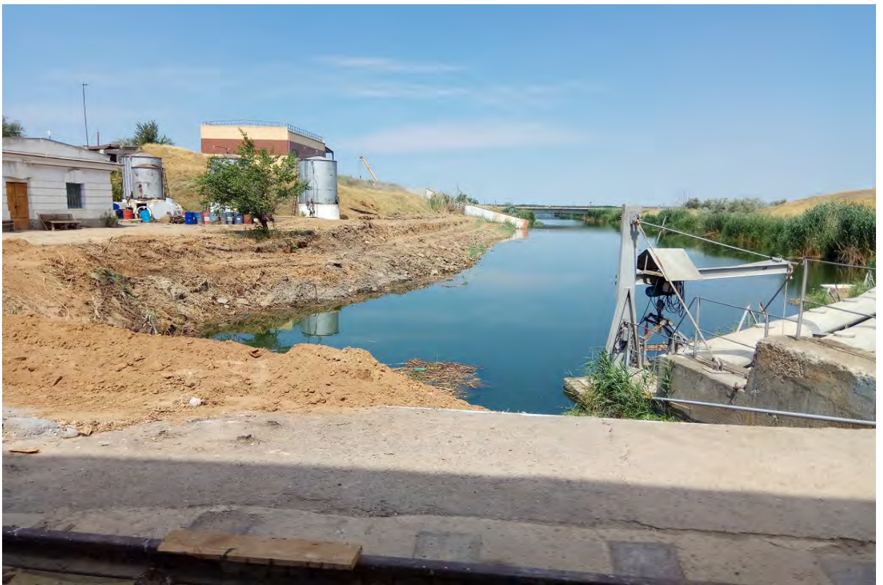
Фото 4. Очистка правого берега подводящего канала до сопряжения с сороудерживающим сооружением.
