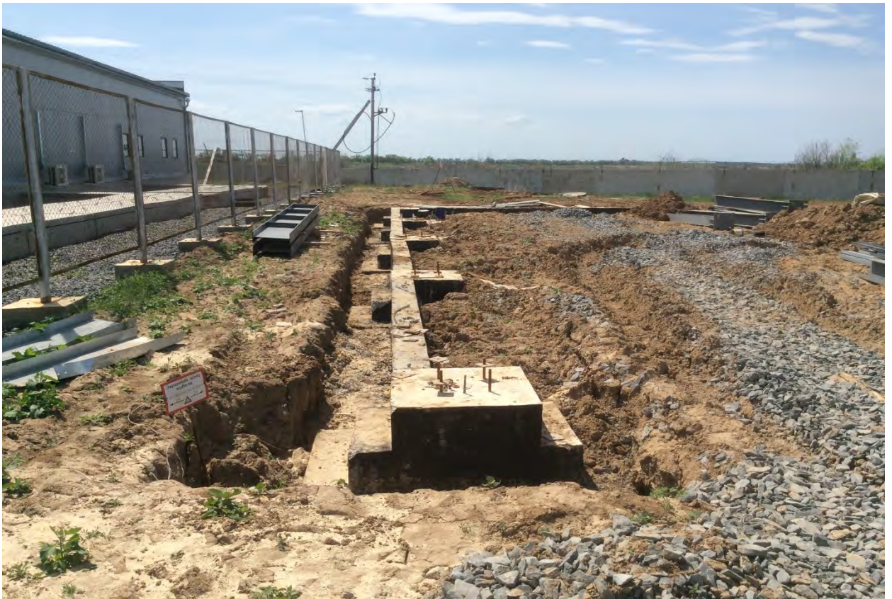
Фото 8. Устройство монолитных фундаментов для монтажа сборных элементов здания энерго-диспетчерского пункта.
