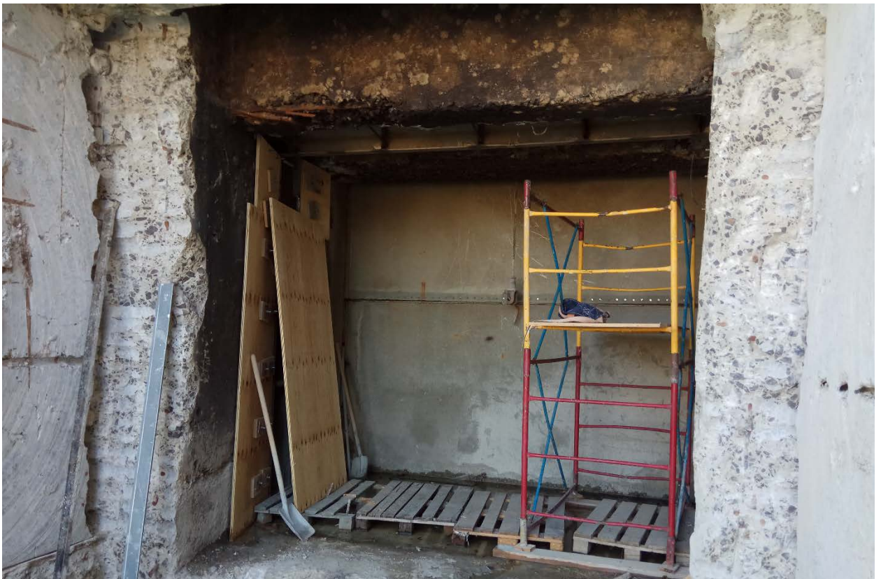
Фото 6,7,8. Установка опалубки для бетонирования закладных уплотнения донного порога и вертикальных путей БПЗ-3 водоприемника №35
