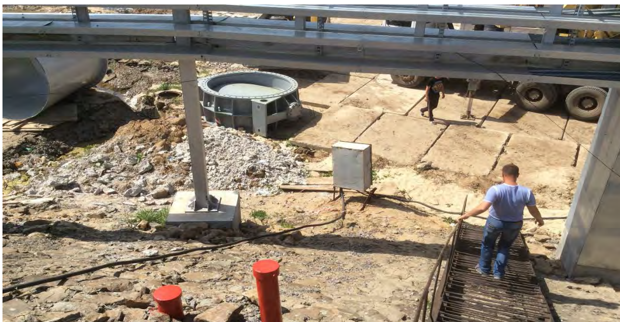
Фото 2. Разгрузка на площадке перед зданием НС №32 дискового затвора и раструба технологического трубопровода
