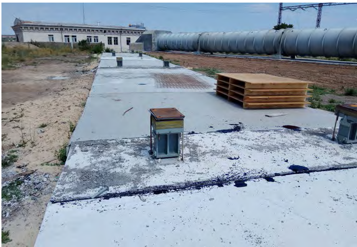
Фото 2. Бетонирование площадок и устройство температурных швов под трубопровод нитки №3
