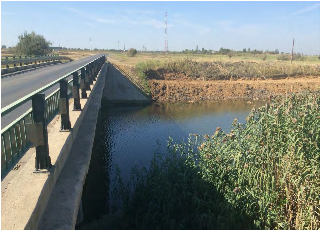
Фото 4,5,6. Зачистка откоса и устройство бермы на участке канала № 135 от автомобильного до железнодорожного моста
