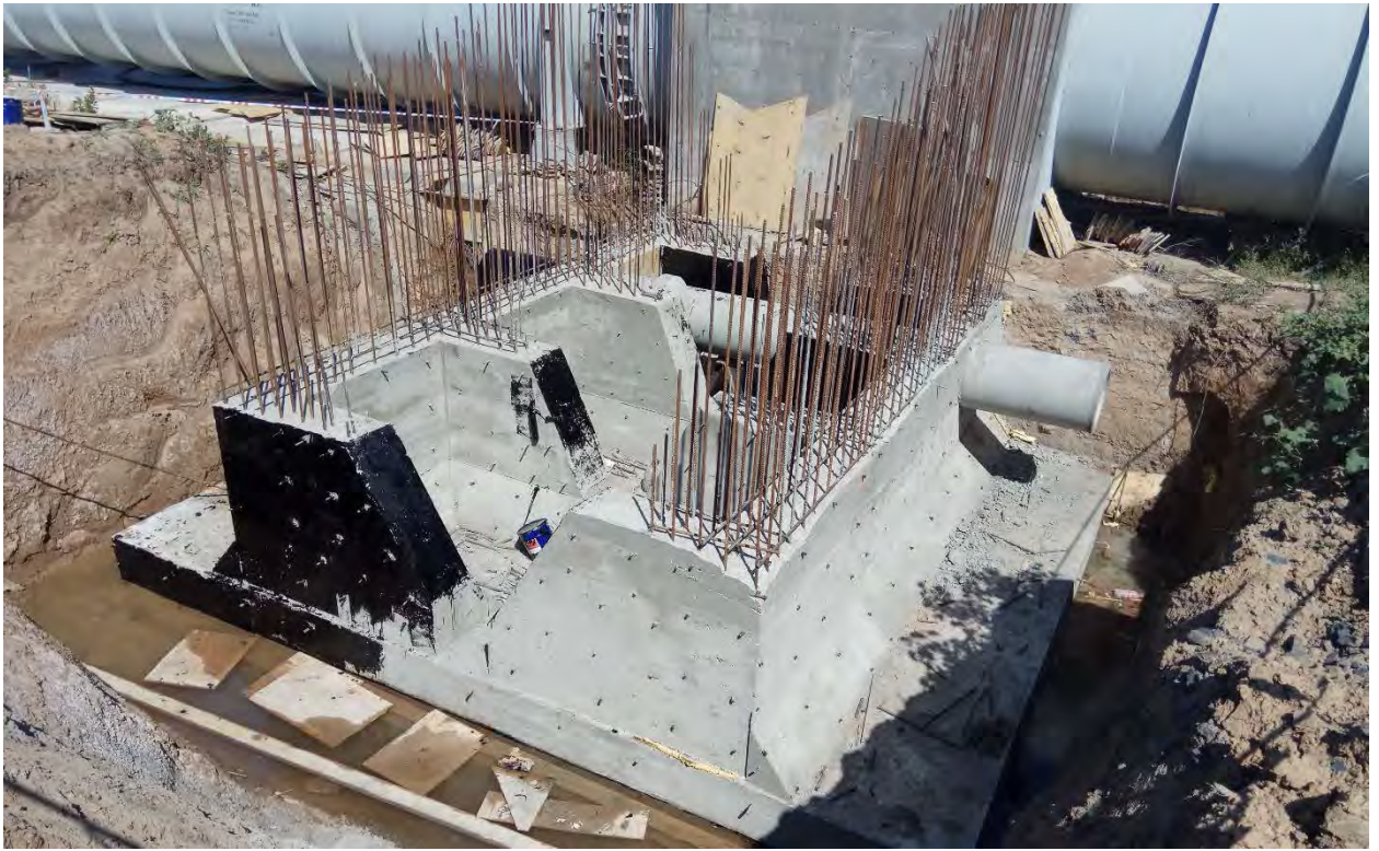
Фото 19,20,21. Устройство стен подпорных проездов через анкерную опору АО-7 трубопровода №2
