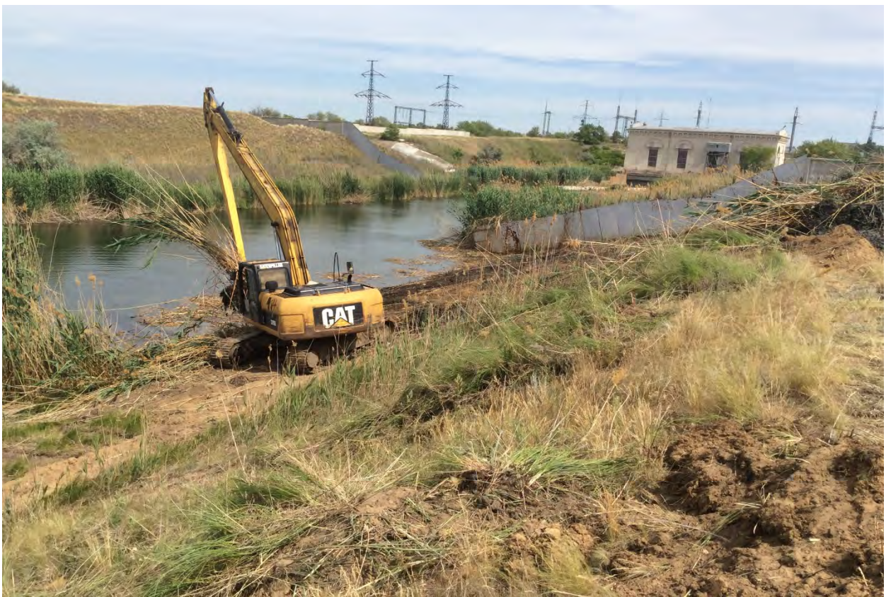
Фото 7. Очистка от растительности и грубая планировка откосов подводящего канала
