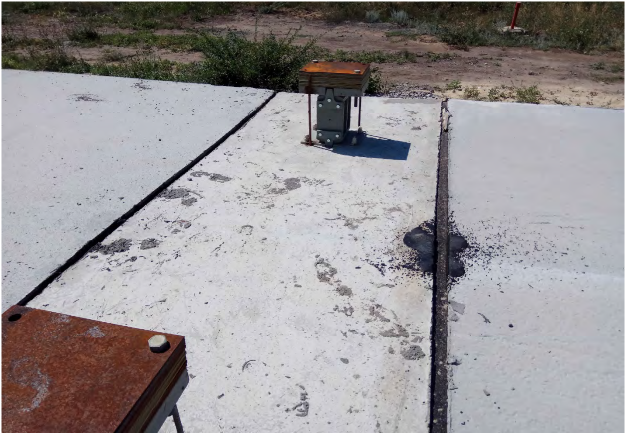
Фото 4, 5. Монтаж анкерных опор трубопровода нитки № 3 и устройство температурных швов на бетонных площадках
