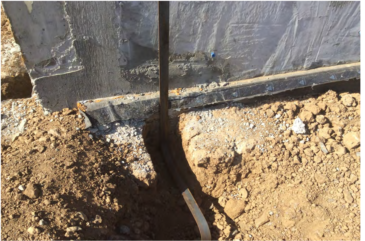
Фото 3. Монтаж контуров заземления здания энерго-диспетчерского пункта
