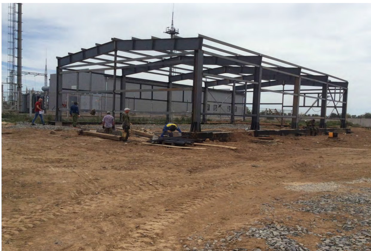
Фото 1,2. Монтаж и сборка металлической рамы несущего каркаса здания энерго-диспетчерского пункта
