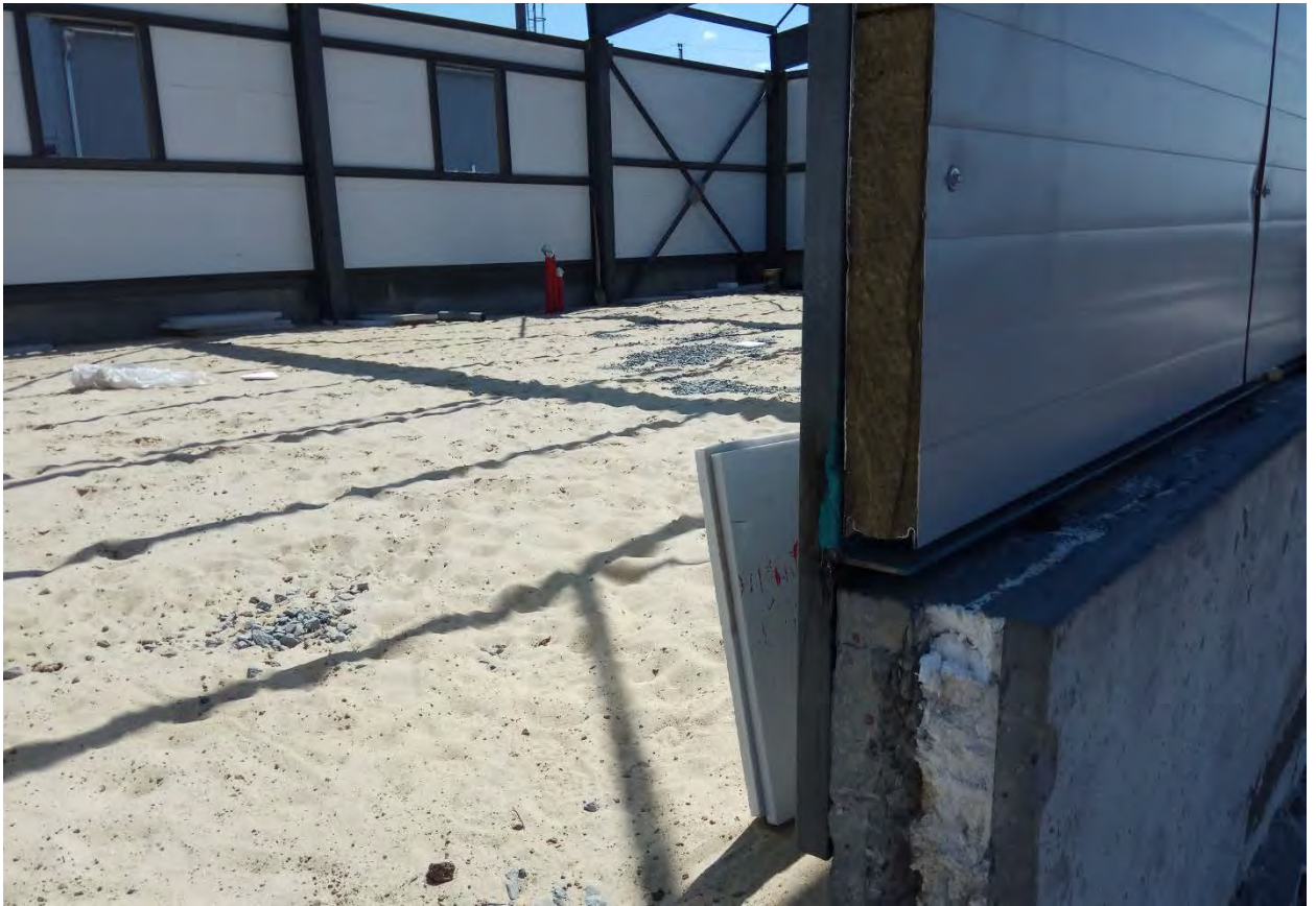
Фото 1, 2, 3. Монтаж цокольных и стеновых многослойных панелей здания энергодиспетчерского пункта, устройство песчаной подготовки пола
