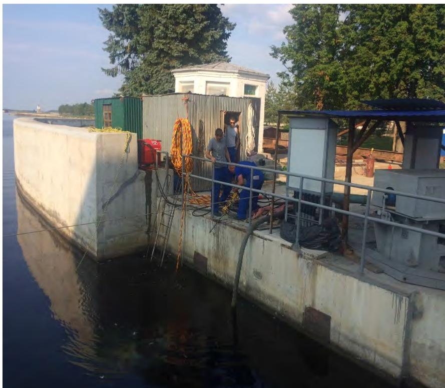
**Демонтаж бетона под установку шпунта.**
