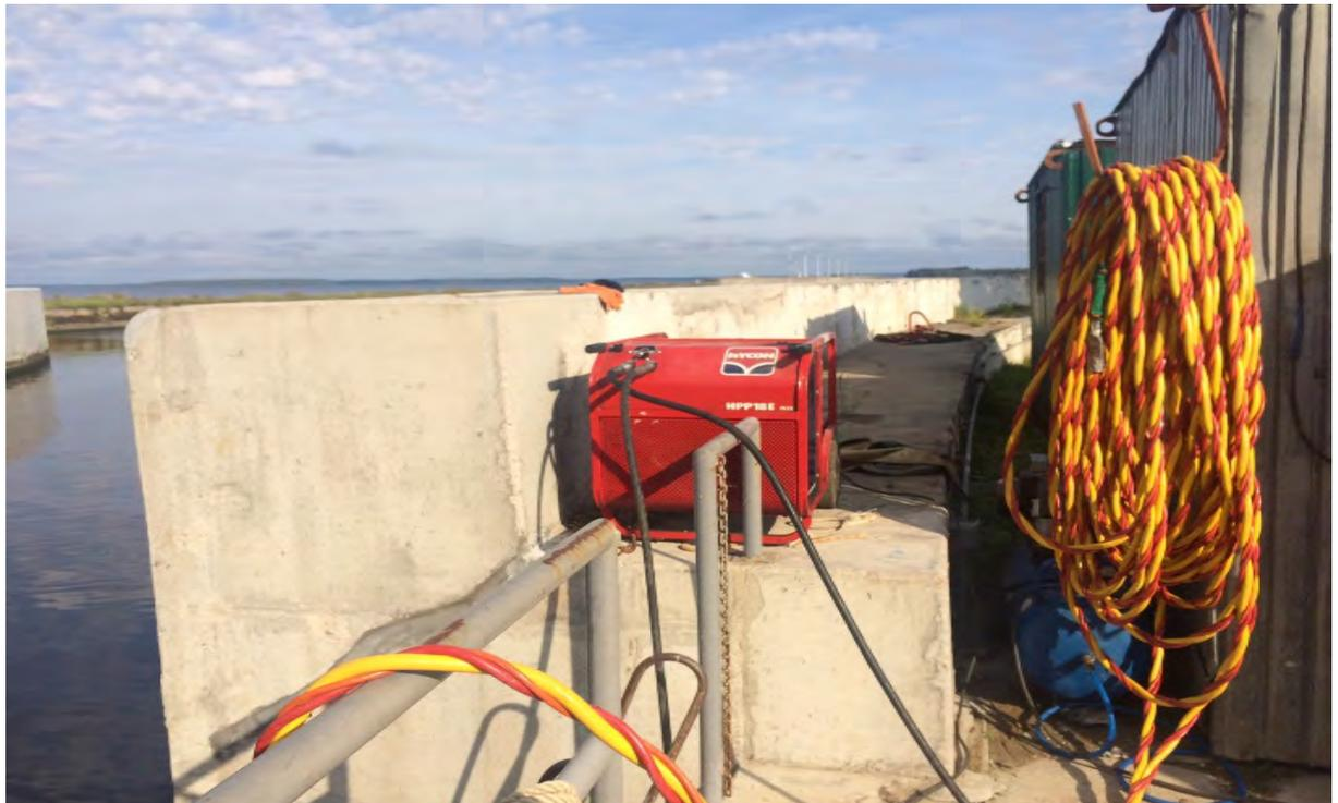
**Установка для демонтажа бетона под водой.**
