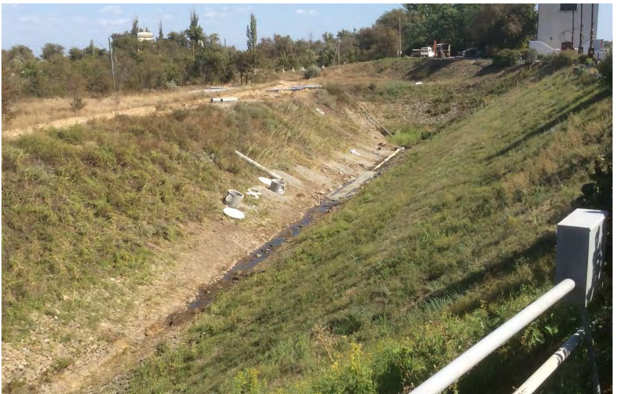
Фото 10. Устройство интенсивного водоотлива до начала реконструкции дренажной ванны на левой стороне шлюза
