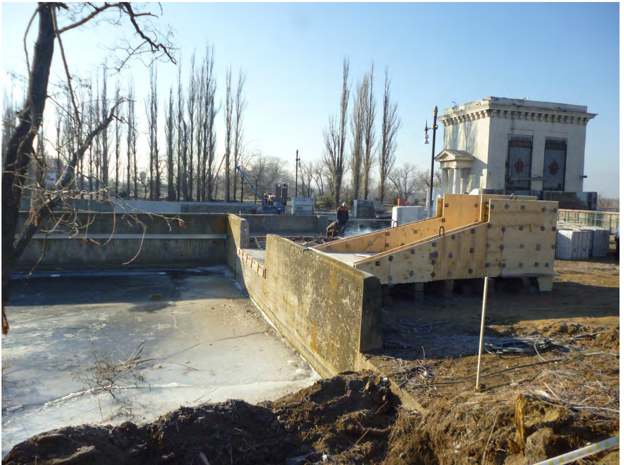
Фото 16. Устройство сифонного оголовка аварийного сброса воды
