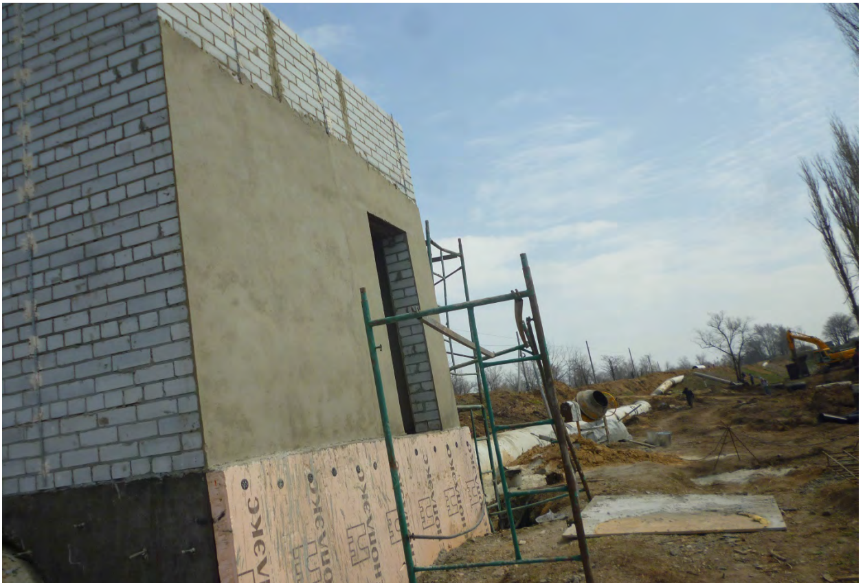
Фото 1, 2. Строительная часть технологических зданий № 1 и 2 сифонного водосброса
