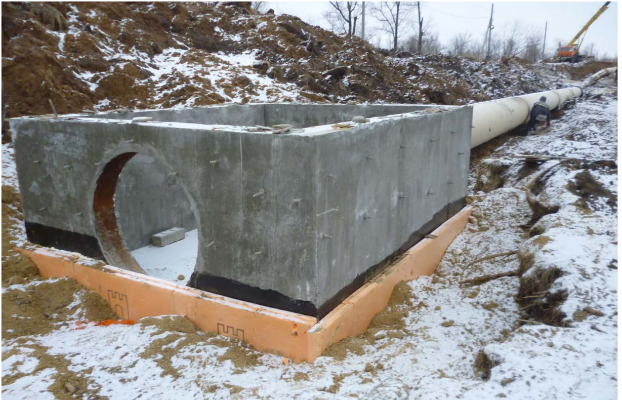
Фото 6. Работы по прокладке трубы сифонного водосброса через цоколь здания вспомогательного назначения № 2
