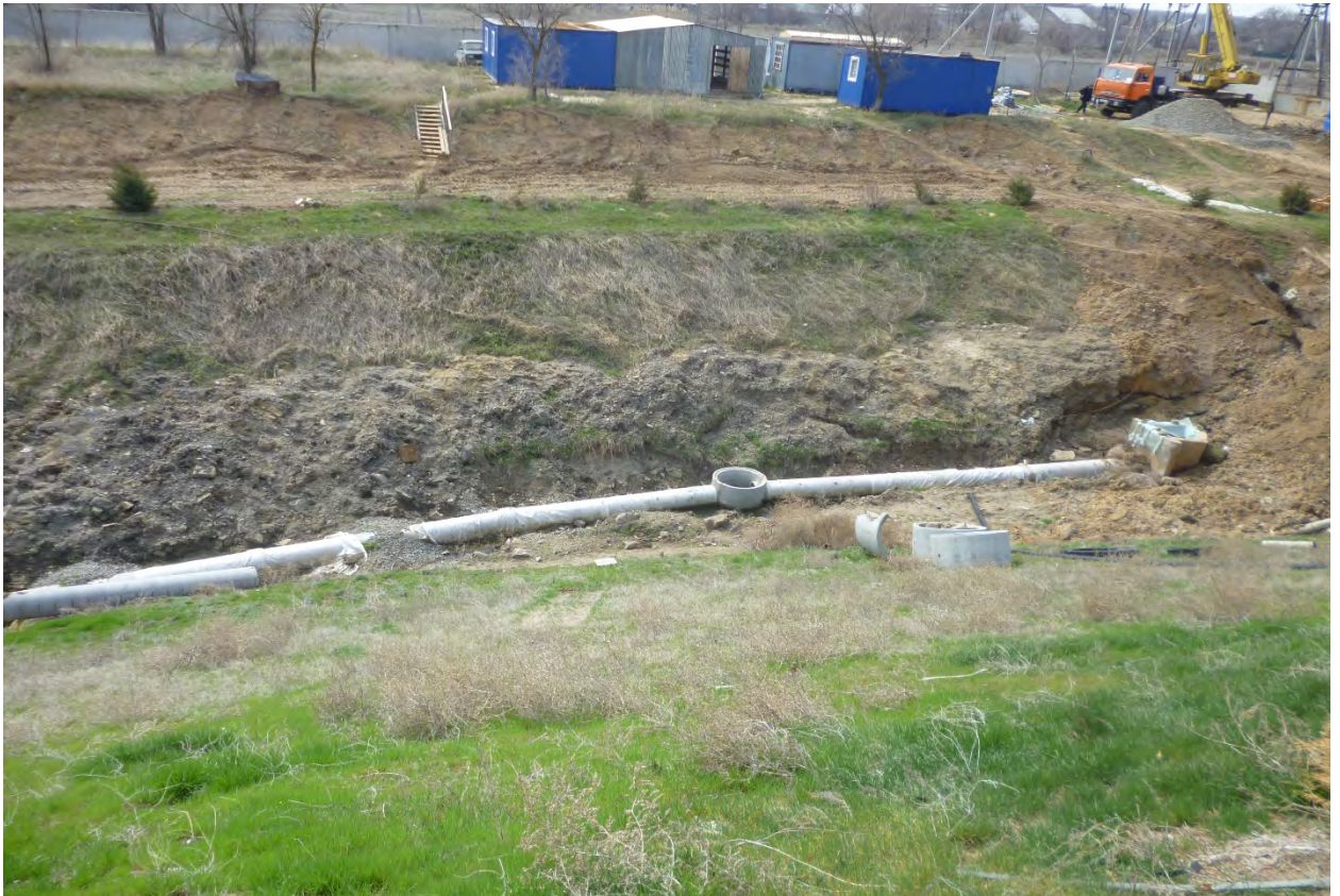
Фото 5. Строительство нижнего участка закрытого дренажа правой дренажной ванны
