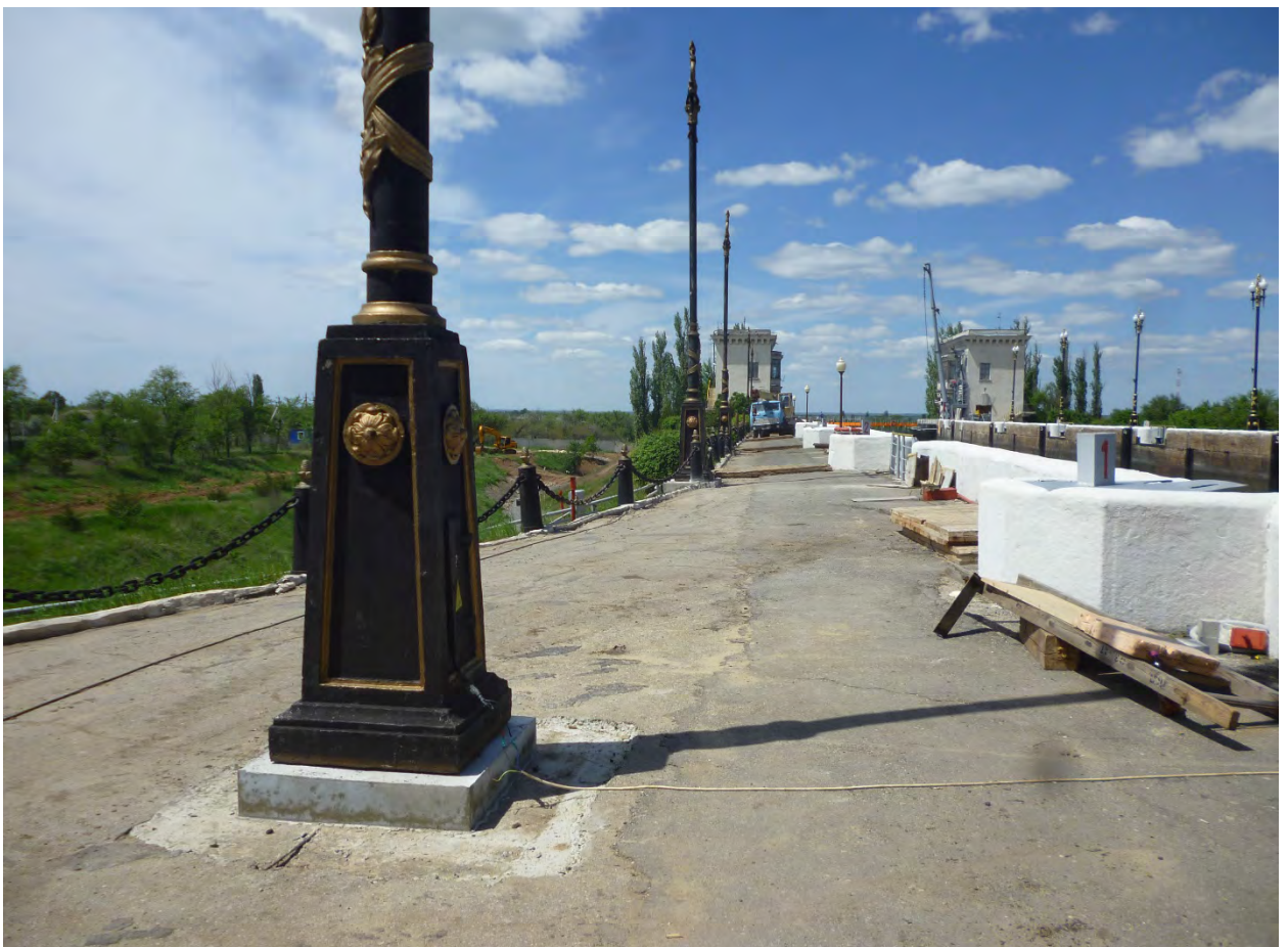
Фото 12-18. Демонтаж существующих опор освещения и фундаментов, прокладка кабельных электрических линий, устройство монолитных железобетонных фундаментов, монтаж и покраска опор освещения
