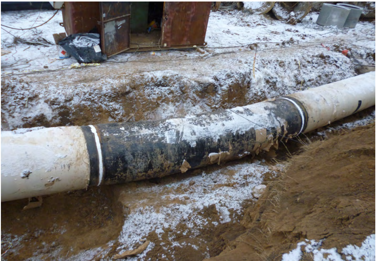
Фото 1-5. Врезка отводов под разными углами на поворотах сифонного водосброса
