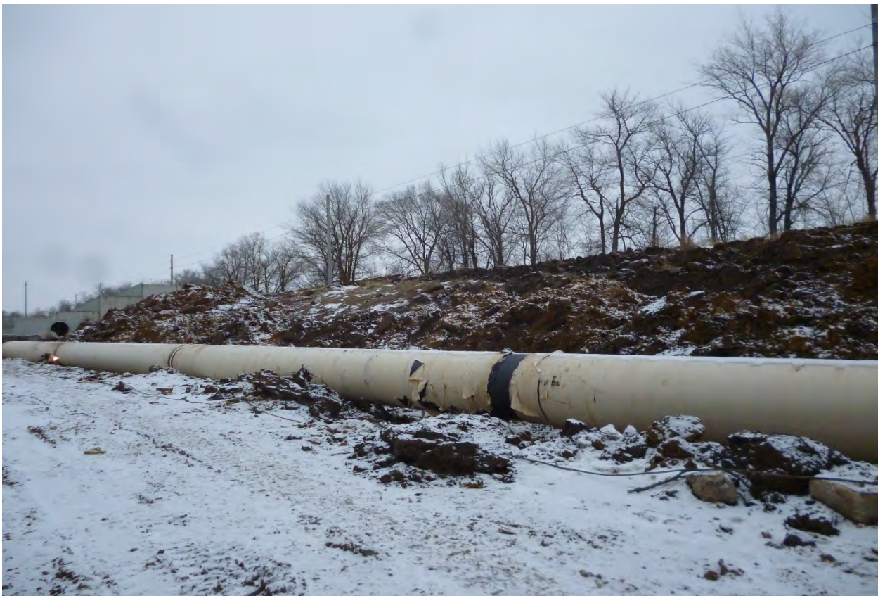
Фото 4,5. Сварка стыков на прямолинейных участках сифонного водосброса
