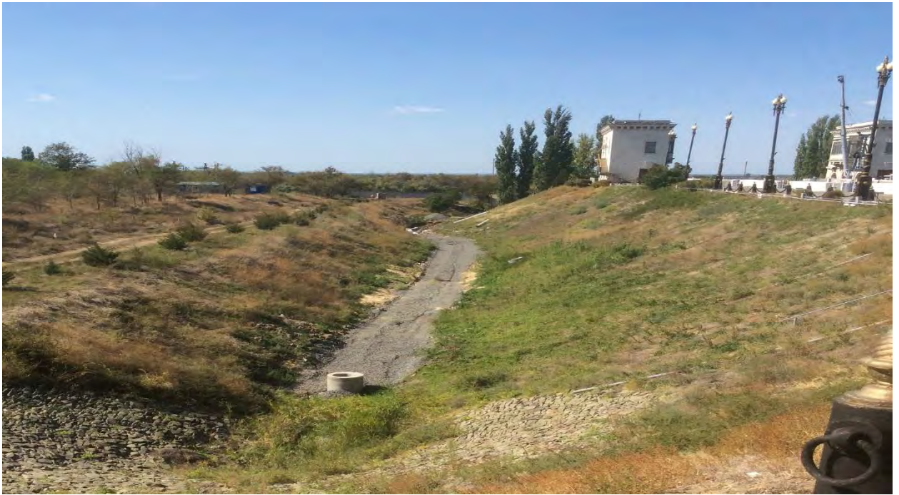
Фото 5,6,7,8,9. Реконструкция правобережной дренажной ванны шлюза, включающая: разборку каменной постели, разработку траншеи, монтаж перфорированных и обмотанных нетканым материалом дренажных труб, установку смотровых колодцев и обсыпку труб фильтрующим материалом (щебнем)
