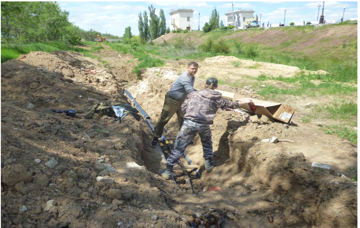
Фото 19,20. Прокладка силовых линий и устройство заземления щитов управления
