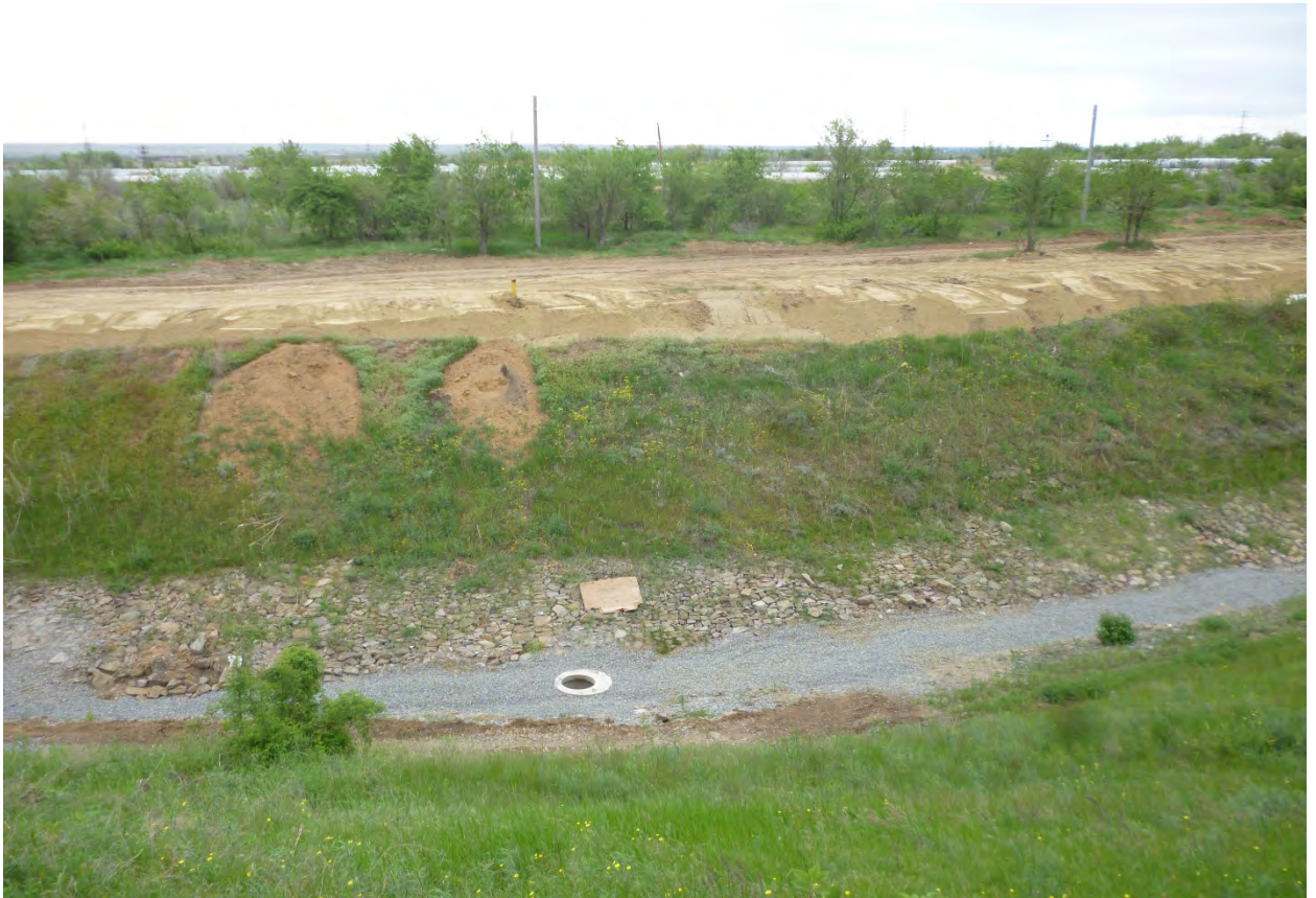
Фото 9,10,11. Засыпка дренажной трубы фильтрующим материалом и монтаж смотровых колодцев на левой дренажной ванне
