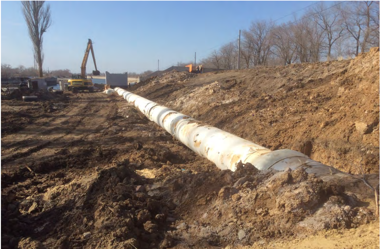
Фото 7,8,9. Участки трубопровода сифонного водосброса, уложены в траншею, готовы к опрессовке и засыпке
