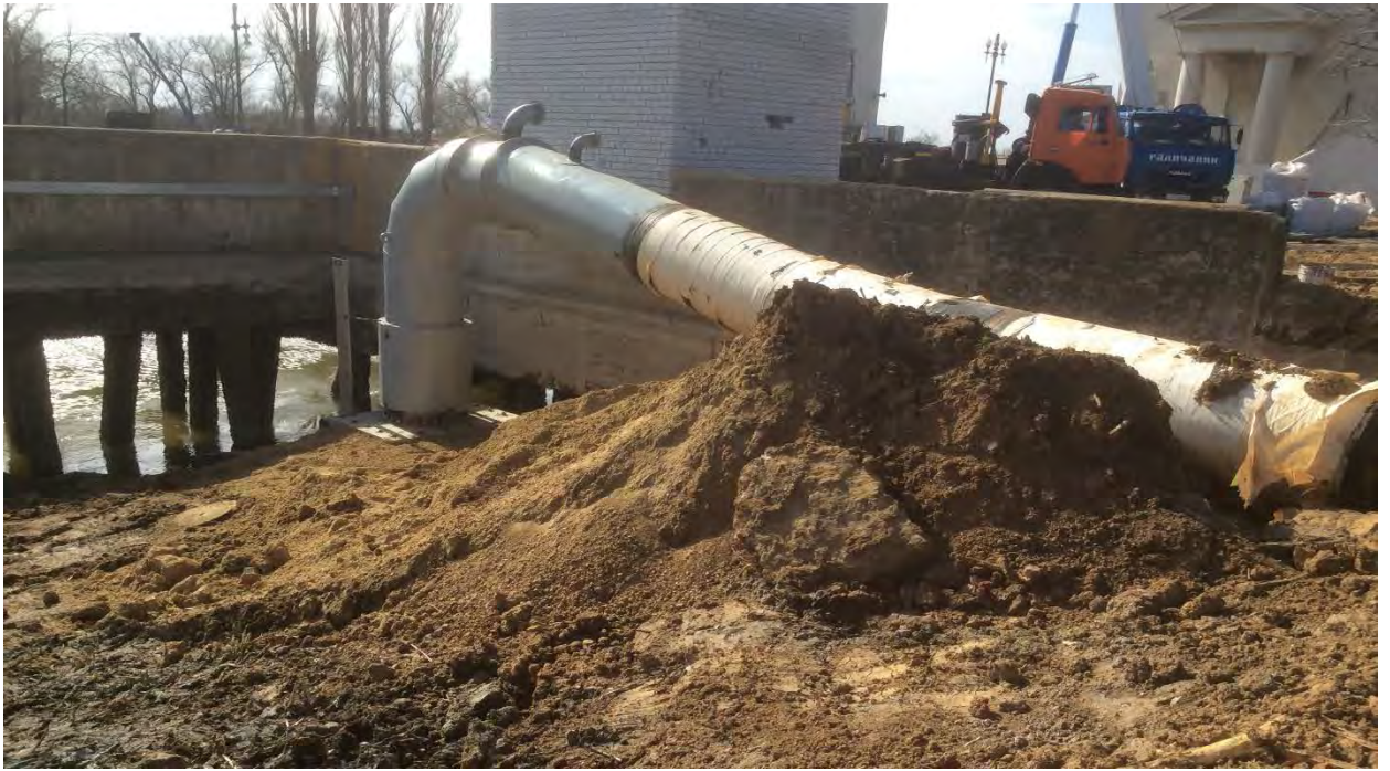
Фото 10. Монтаж колена трубопровода для вакуумной зарядки сифона на всасывающий оголовок
