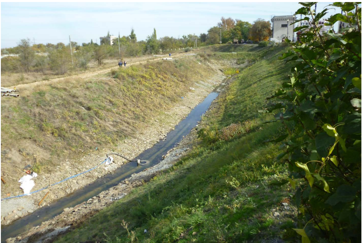
Фото 10. Временное затопление труб и колодцев левой дренажной ванны на период строительства отводящего коллектора
