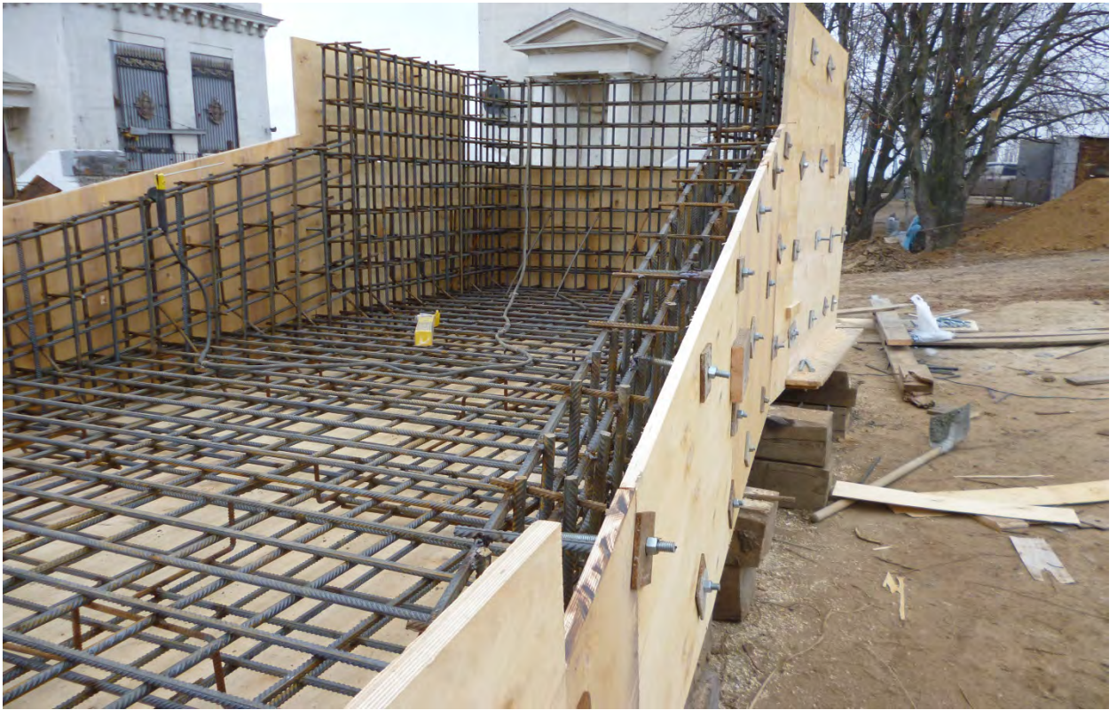
Фото 17. Армирование и монтаж опалубки сифонного оголовка
