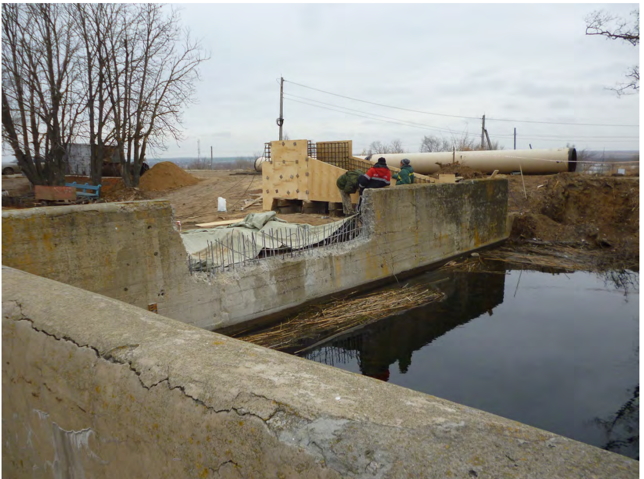
Фото 18. Вырубка проема в ограждающей стенке и устройство плиты основания для оголовка
