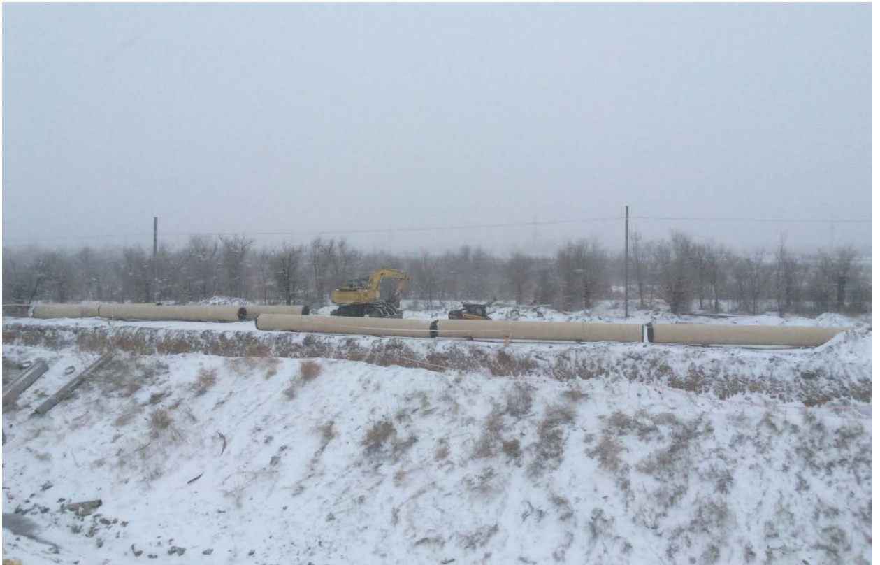
Фото 19,20,21. Устройство траншеи и раскладка труб сифонного водосброса
