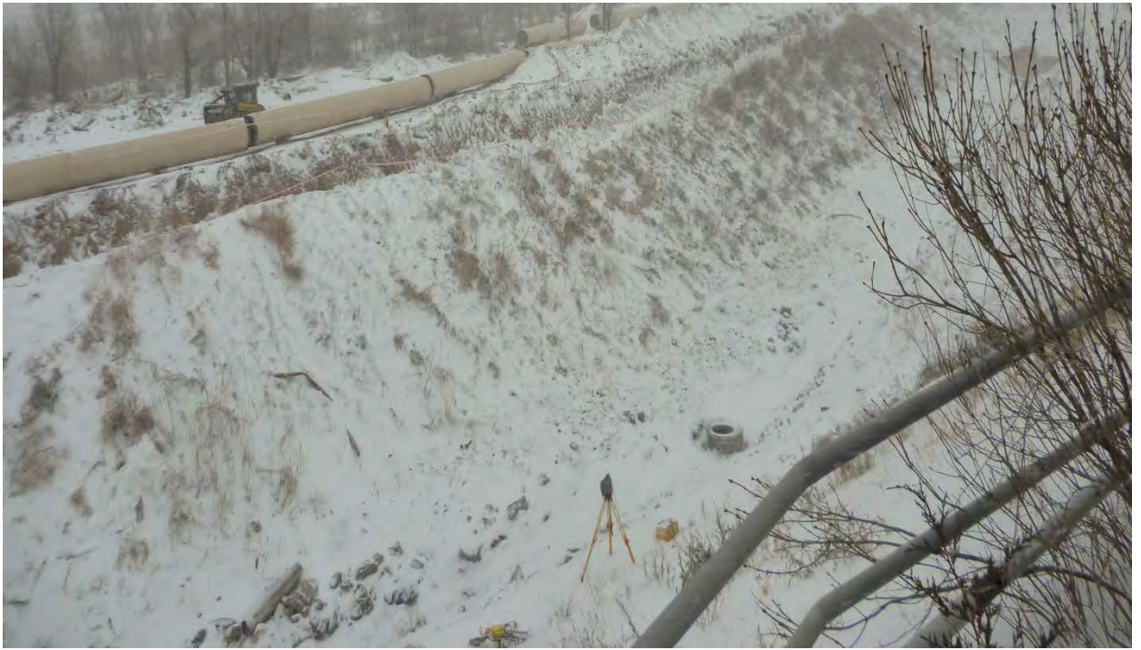
Фото 11. Нивелирный контроль отметок при монтаже дополнительных колец смотровых колодцев
