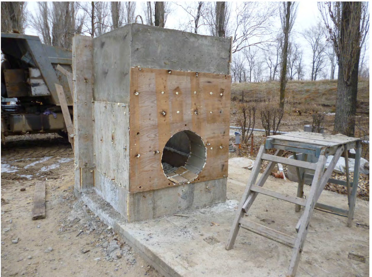
Фото 22. Устройство опоры для подключения колена сифонного сброса
