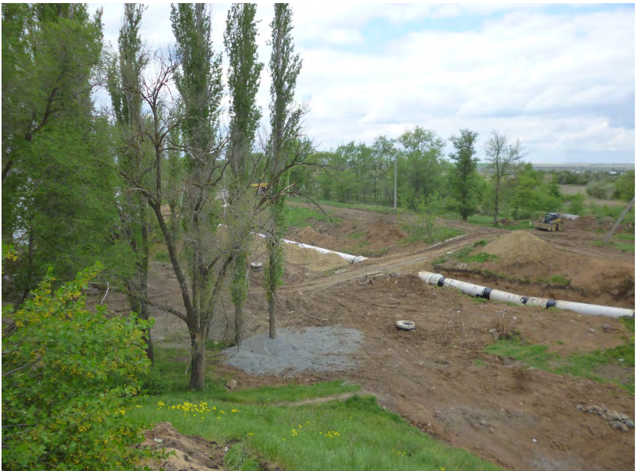
Фото 3,4. Установка защитных кожухов диаметром 1220 мм на переездах трубы сифонного водосброса
