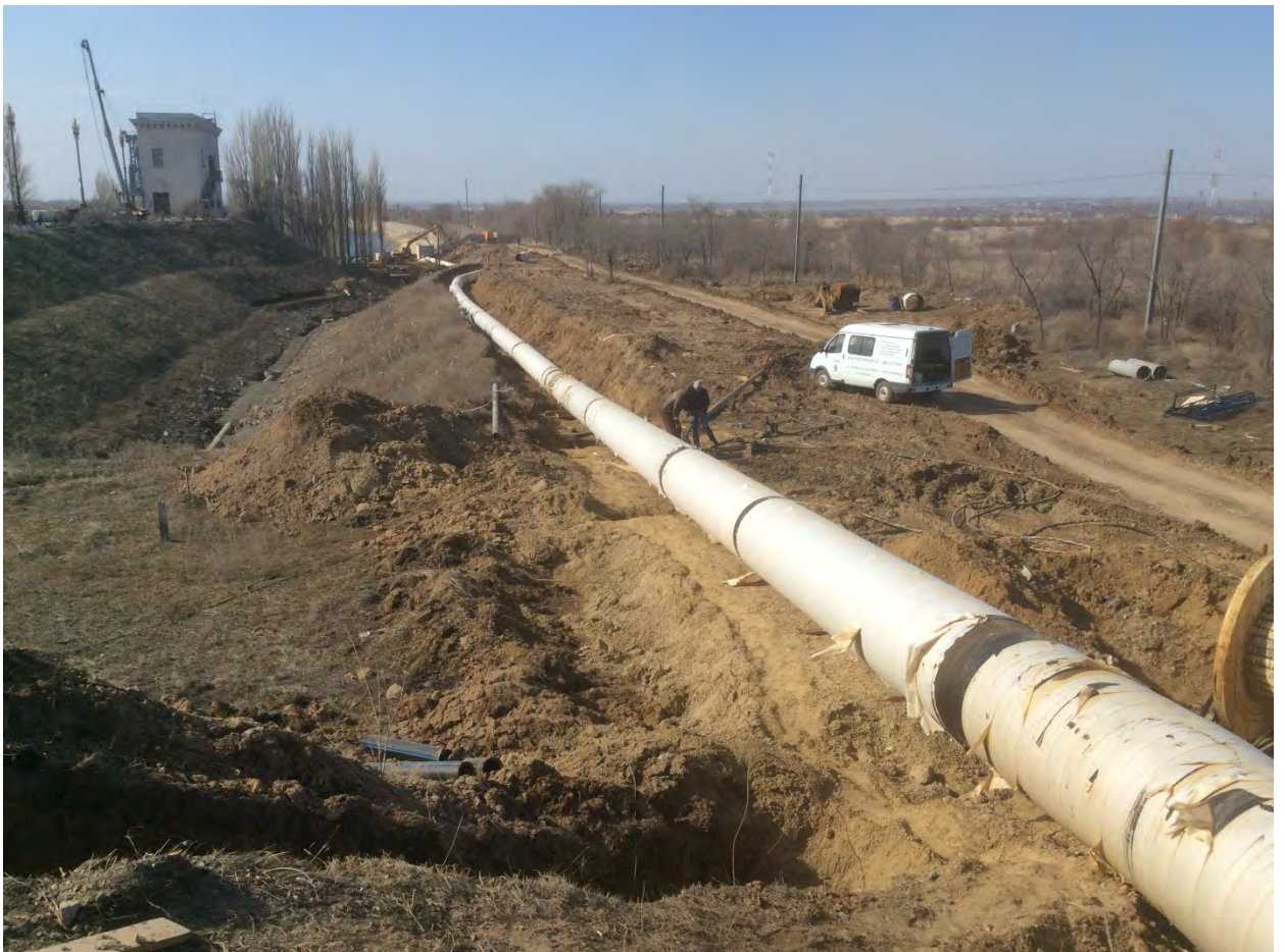
Фото 6. Работы по прокладке трубы сифонного водосброса через цоколь здания вспомогательного назначения № 2
