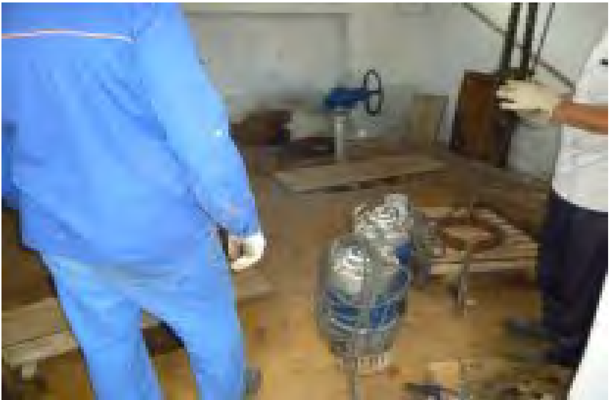
Фото 4. Демонтаж артезианских насосов осушения камеры шлюза из шахтных колодцев
