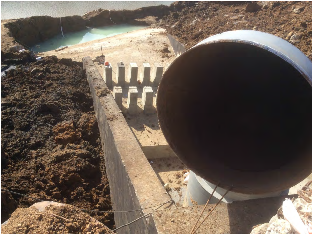
Фото 11. Устройство оголовка-гасителя сифонного водосброса Марининского гидроузла
