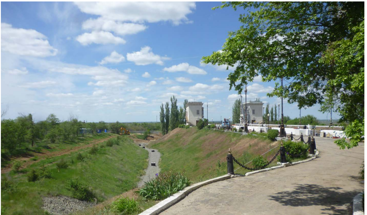
Фото 6,7,8. Засыпка фильтрующим материалом (щебнем) дренажных труб правой дренажной ванны и монтаж крышек на смотровые колодцы
