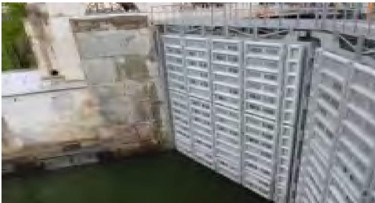
Фото 1. Регулировка веревяльных и лобового уплотнений нижних двустворчатых ворот после монтажа
