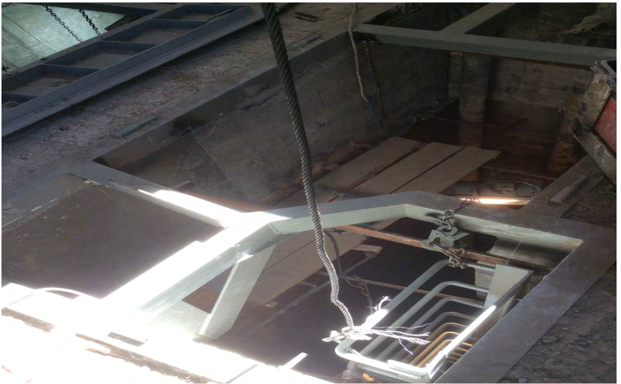
Фото 3, 4. Монтаж и крепление металлоконструкций оформления колодцев для погружных насосов и монтаж трехсекционных лестниц
